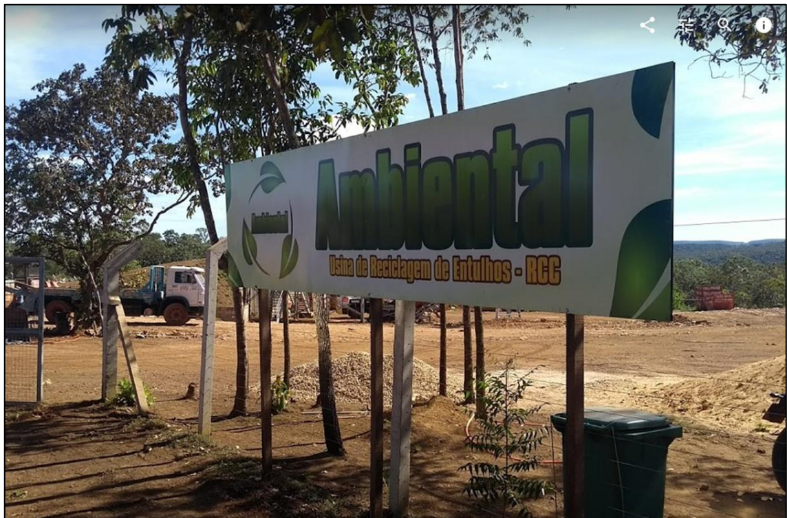
Figura 17: Entrada da usina de reciclagem de RCC.
