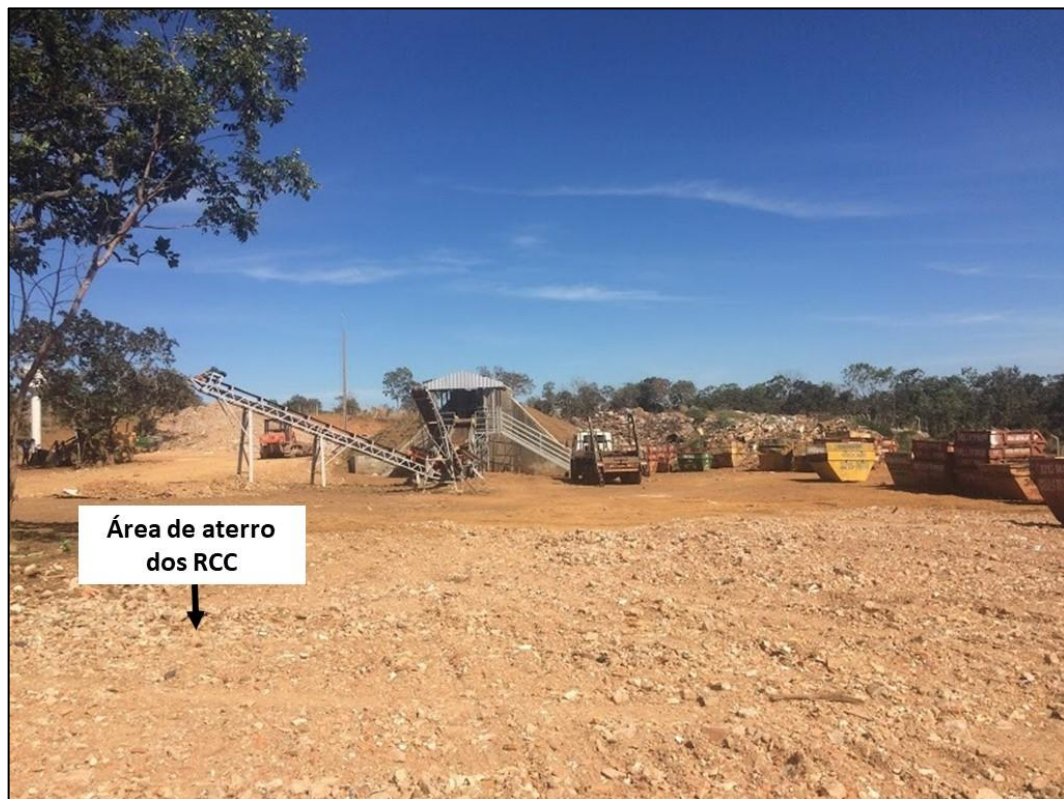
Figura 25: Área na usina destinada ao aterro dos resíduos classe A.
