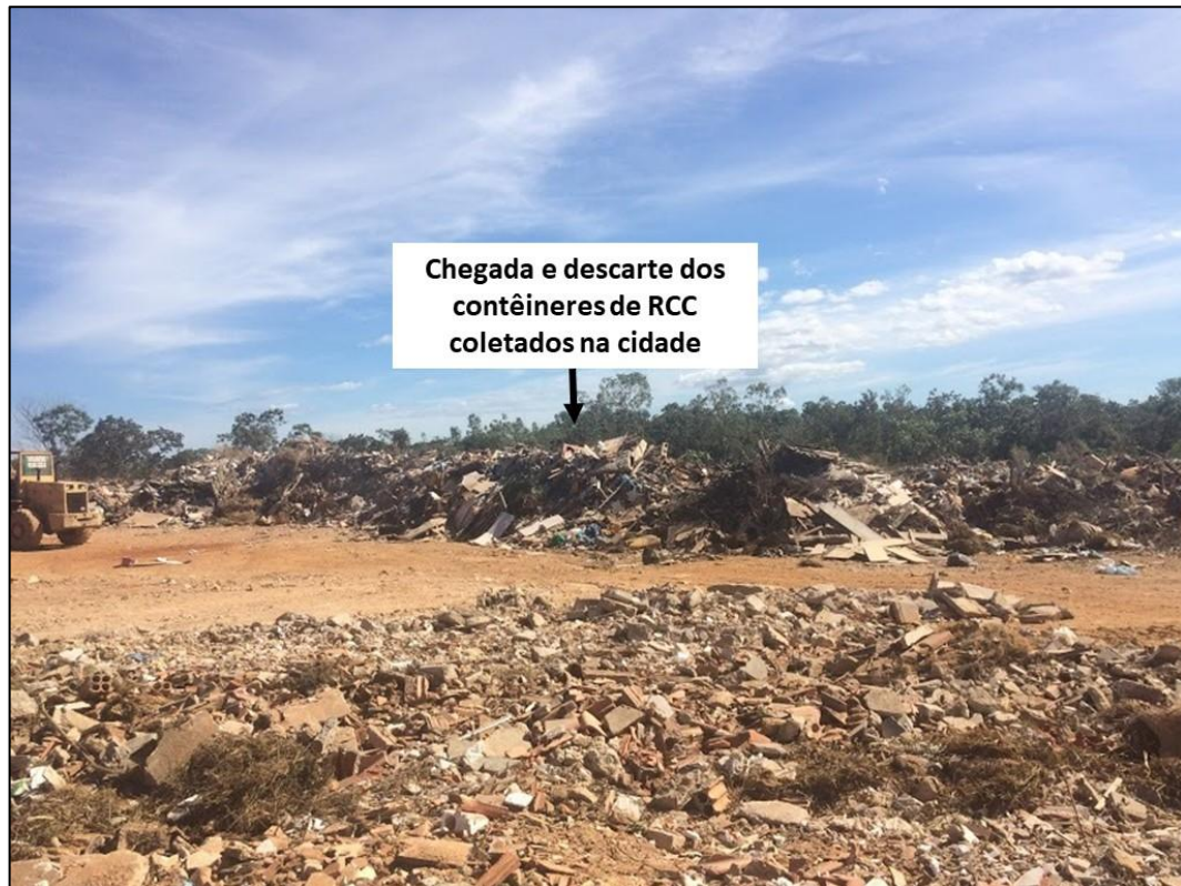
Figura 18: Chegada dos resíduos na usina de reciclagem de RCC.
