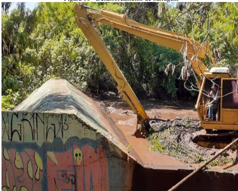
Figura 10 - Desassoreamento de barragem
