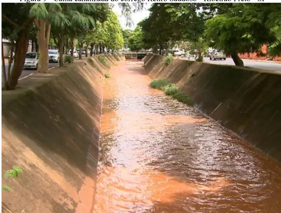
Figura 9 - Calha canalizada do córrego Retiro Saudoso - Ribeirão Preto - SP
