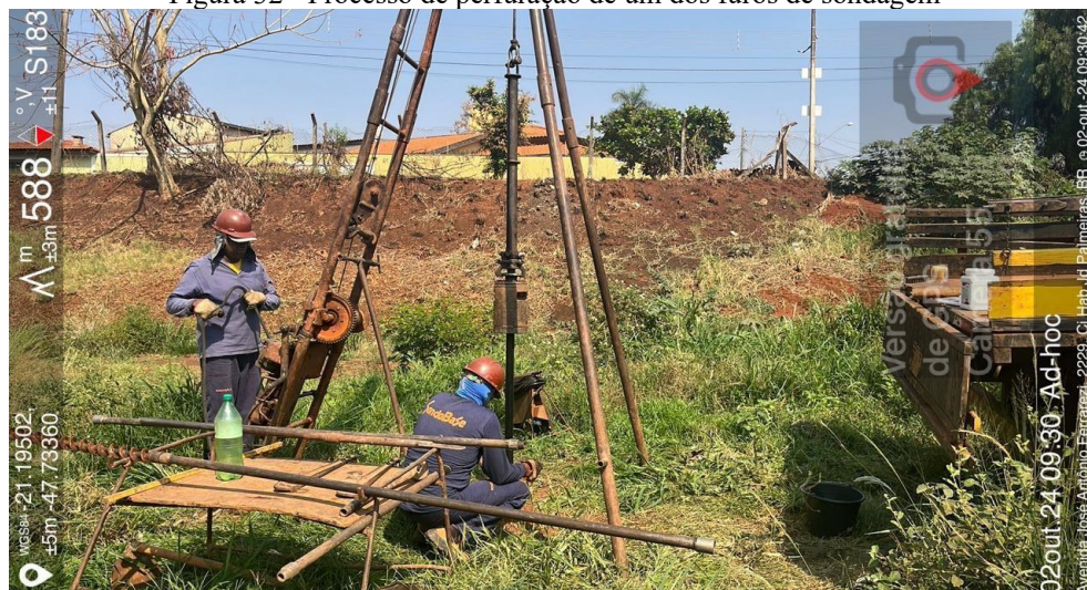
Figura 32 - Processo de perfuração de um dos furos de sondagem
