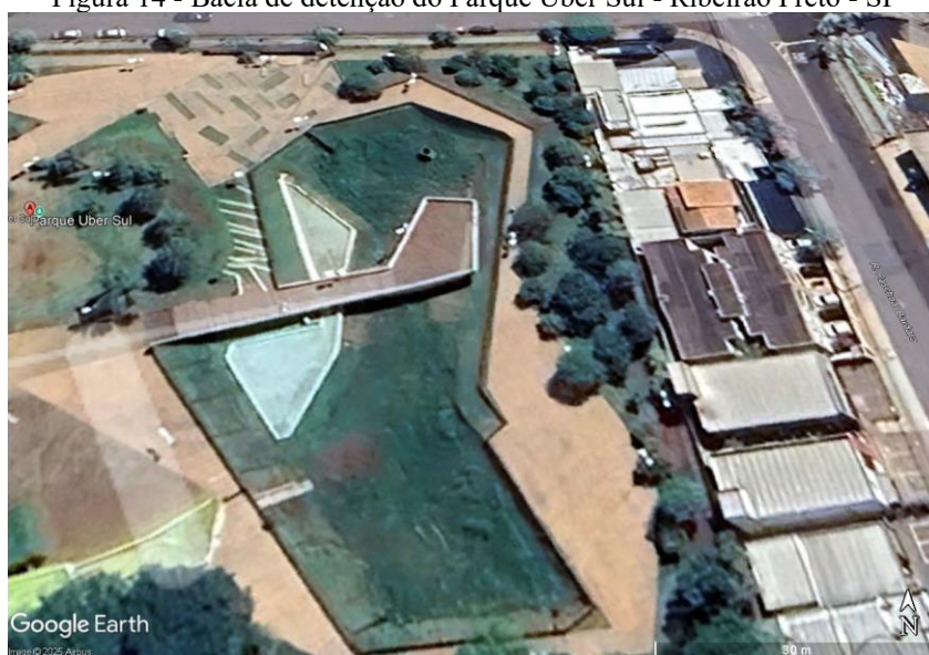
Figura 14 - Bacia de retenção do Parque Über Sul - Ribeirão Preto - SP
