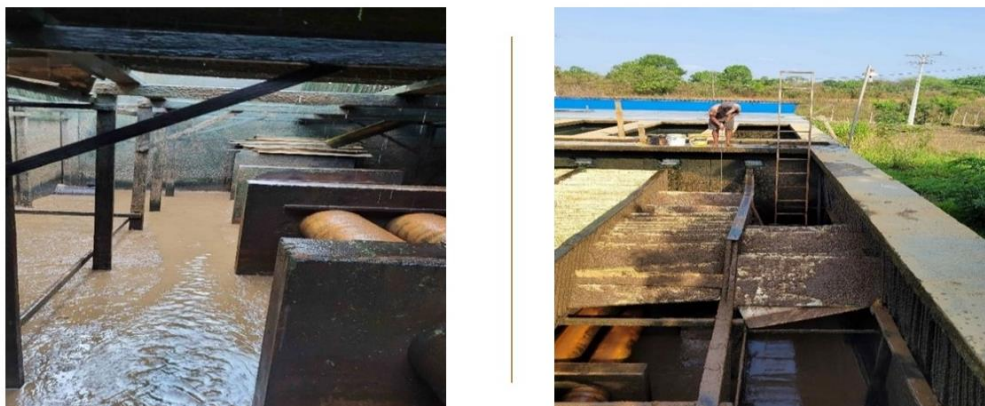
Figura 14 Decantador onde foram realizadas as coletas do resíduo
