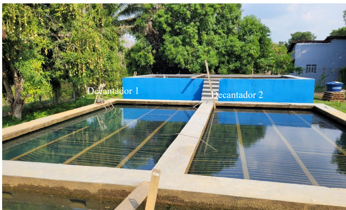
Figura 37 Decantadores da ETA
