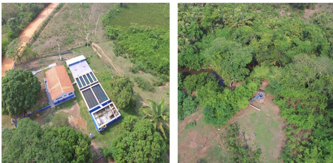
Figura 12 Vista aérea da ETA de Araguatins e do ponto de coleta de água
