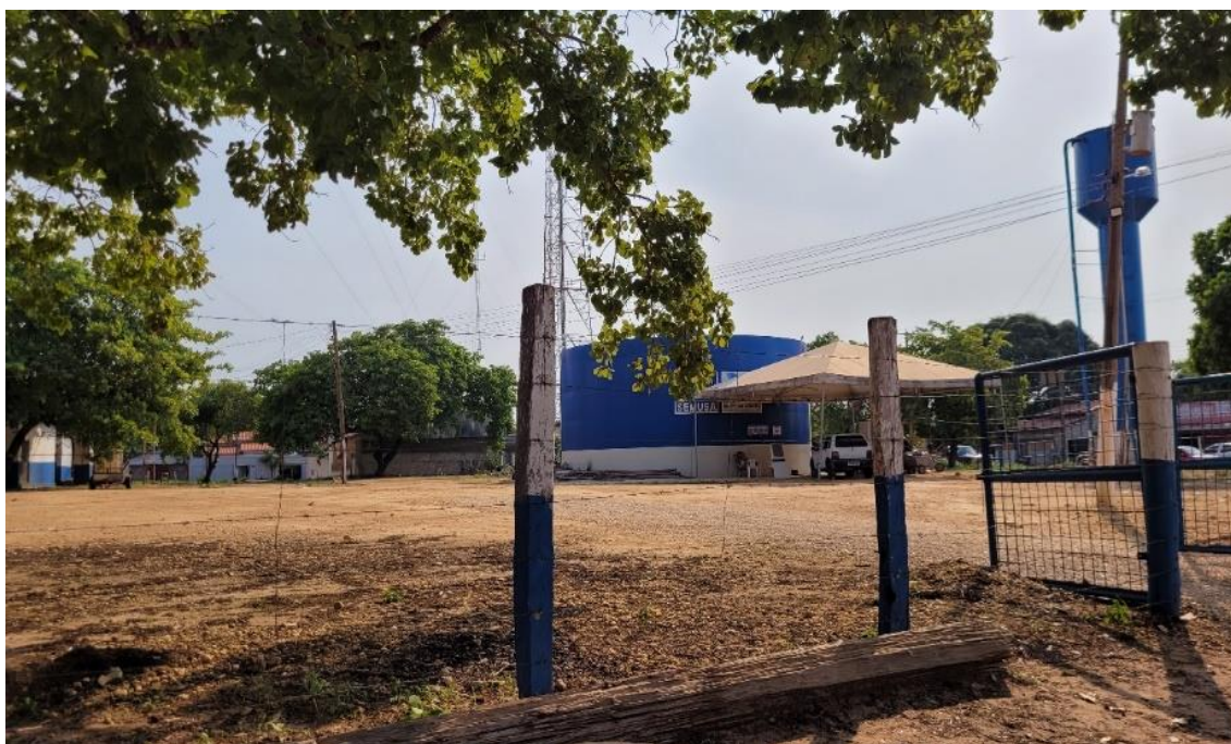
Figura 40 Centro de armazenamento e distribuição 2
