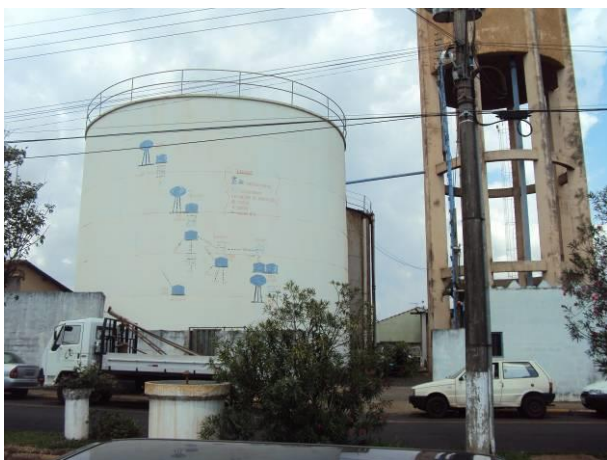
Figura 03. Vista do reservatório apoiado existente no CRD1.
