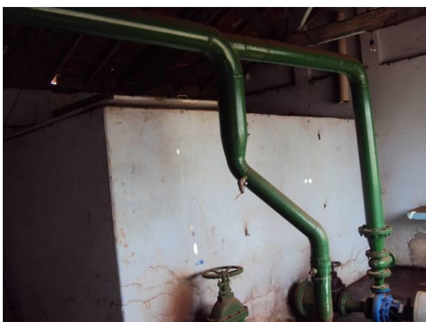
Figura 09. Caixa de alvenaria existente para armazenar a água produzida no poço nº04.
