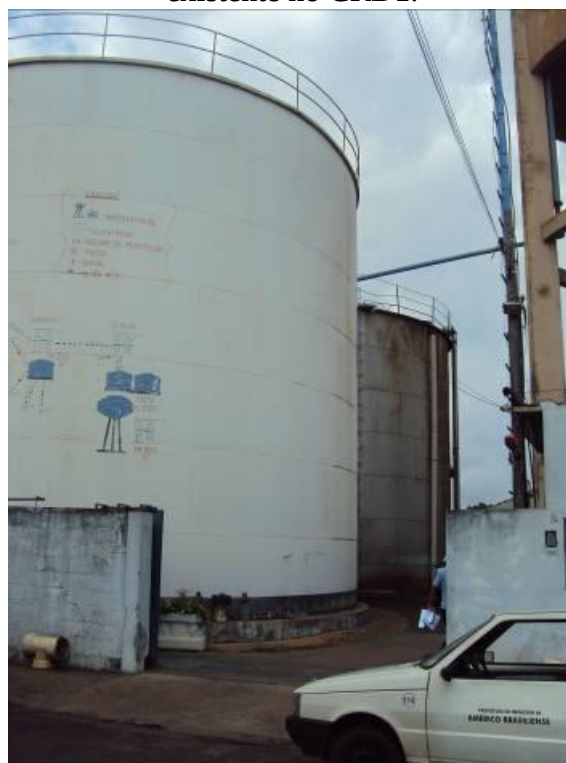
Figura 06. Vista do reservatório apoiado existente no CRD1.
