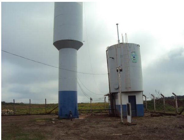
Figura 18. Reservatórios existentes no CRD2.
