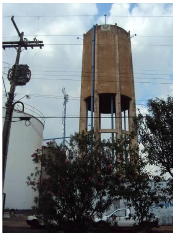
Figura 04. Vista do reservatório elevado existente no CRD1.
