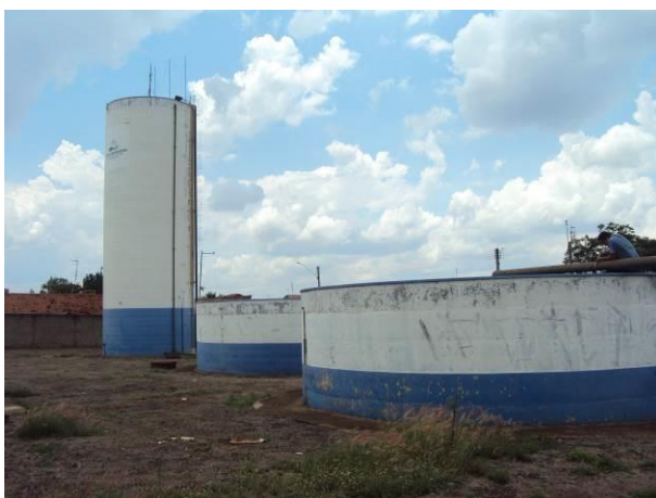
Figura 20. Vista dos reservatórios existentes no CRD3.
