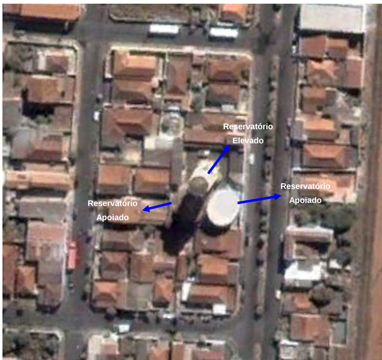
Figura 02. Vista do Centro de Reservação 01 (CRD1).
