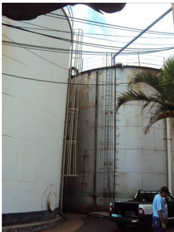
Figura 05. Vista do reservatório apoiado existente no CRD1.
