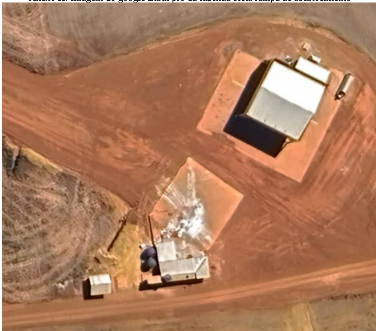
Anexo H: Imagem do google Earth pro da fazenda bieta rampa de abastecimento
