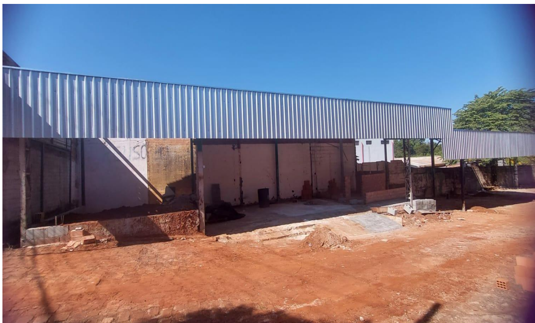
Figura 25 – Local de instalação da cooperativa, durante a construção das instalações
