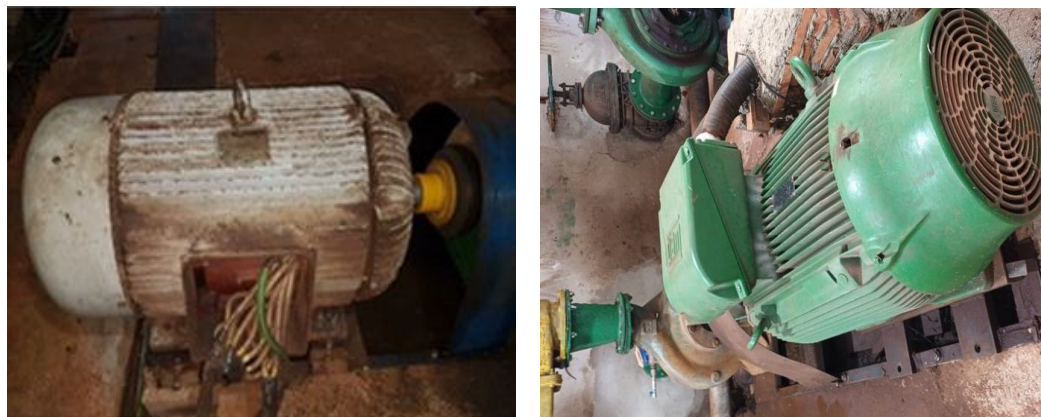
Figura 43 – Motor de baixo rendimento à esquerda e motor novo de alto rendimento à direita instalados em EEAT da Empresa Pública de Saneamento.
