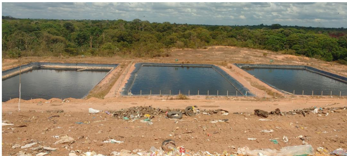
Figura 26 - Aterro Sanitário de Macapá: Poços rasos para verificação do nível de percolamento, isso ocorre mensalmente
