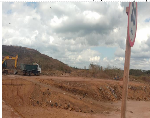
Célula de operação do Aterro Sanitário
