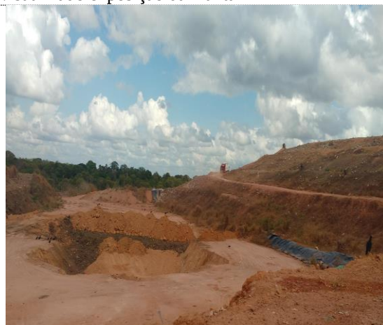
Célula de operação, visualizado exposição da manta
