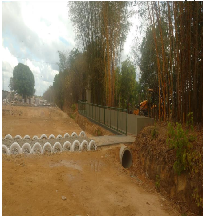
Entrada de acesso ao novo espaço dos Associados, diferente da entrada do aterro sanitário
