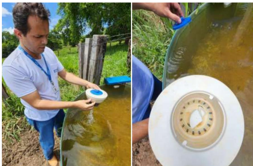
Figura 10- Verificação da regulagem do suporte de Cloro e da quantidade de Cloro depositado no suporte.
