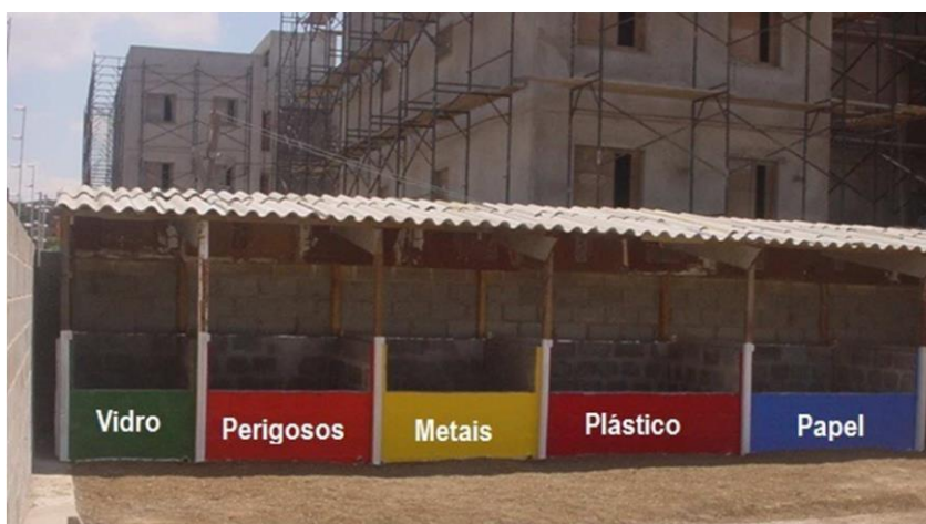
Figura 12 – Canteiros de obras com separação de RCC
