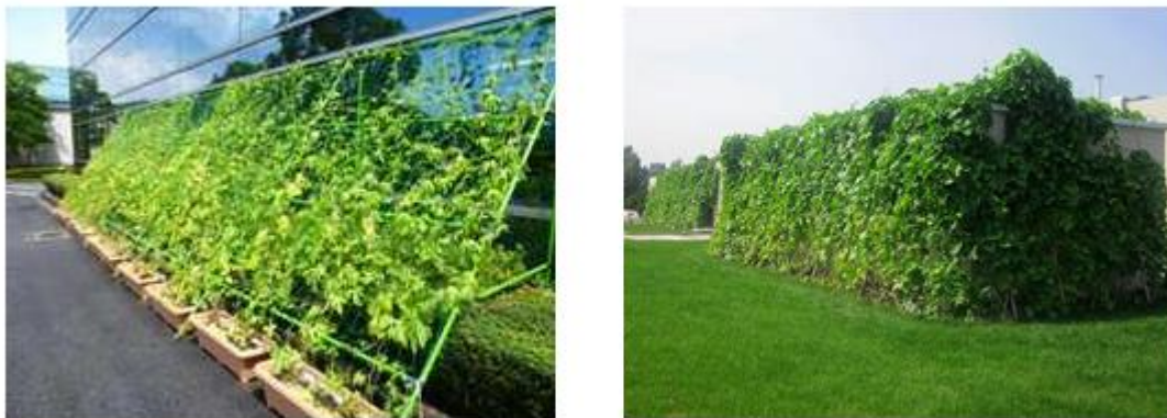
FIGURA 24 - Cortinas verdes protegendo as paredes externas e janelas das instalações do Grupo Kyocera (À esquerda: Hiroshima, Japão. À direita: Tianjin, China)
