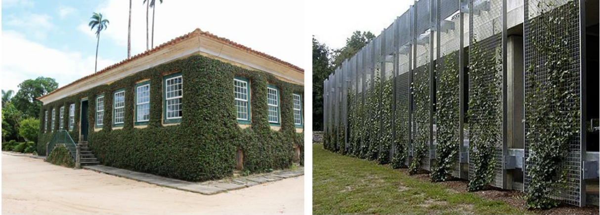
FIGURA 10 – À esquerda, fachada do Museu Casa da Hera, Vassouras-RJ (fachada direta); à direita, instalação de estrutura para fixação e crescimento de plantas em cortinas verdes (fachada indireta)
