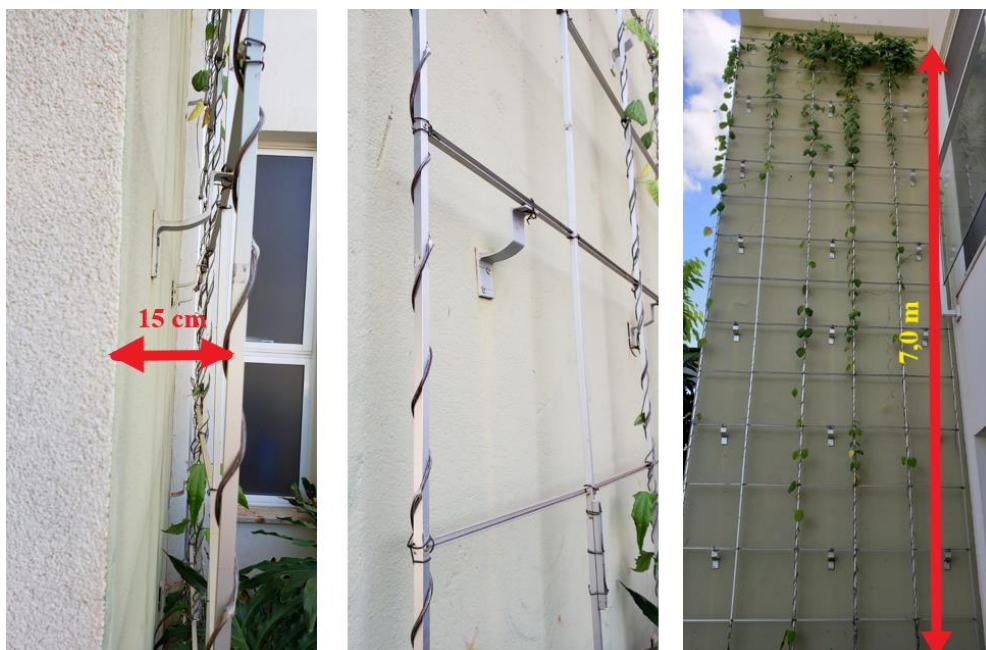
FIGURA 20 – Estrutura experimental com perfil de alumínio
