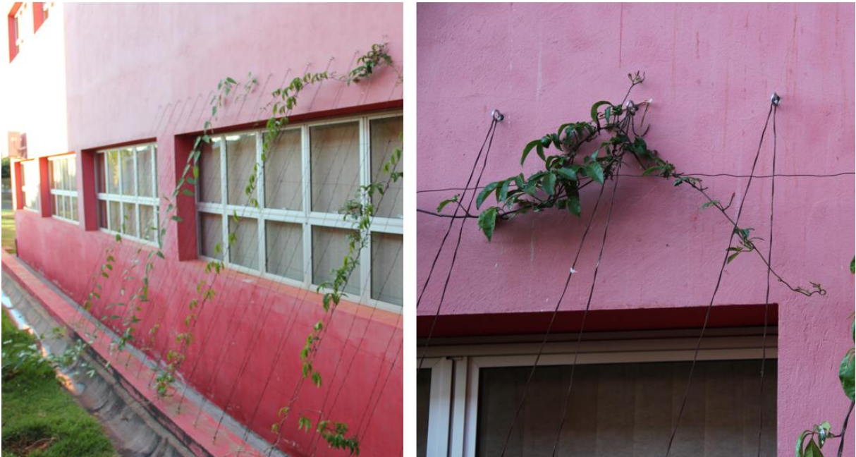
FIGURA 21 - Cortina verde com estrutura de arame e pitões
