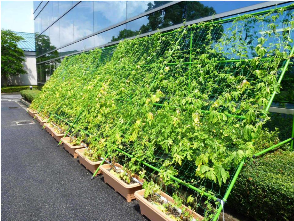
FIGURA 19 - Cortina verde com possíveis estruturas com material rígido – metálico ou plástico – e tela flexível
