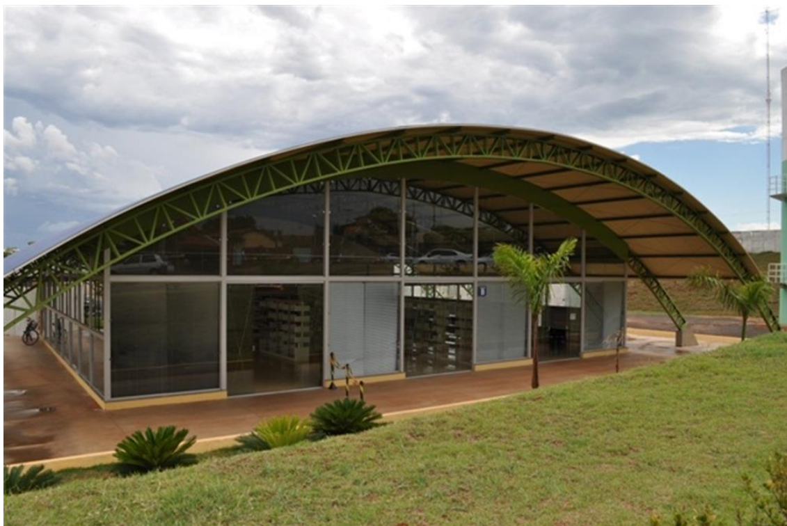
FIGURA 45 - Fachadas Norte (frontal) e Leste (lateral à esquerda)
