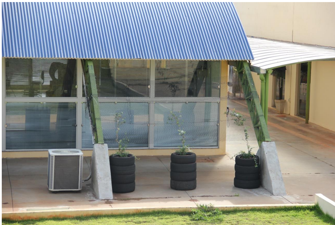
FIGURA 51 - Sugestão de plantio das mudas em vasos entre os vãos da estrutura metálica
