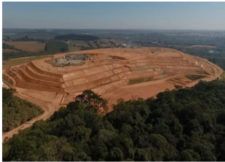
Figura 8 - Aterro sanitário - Fazenda Rio Grande, na região de Curitiba, Paraná
