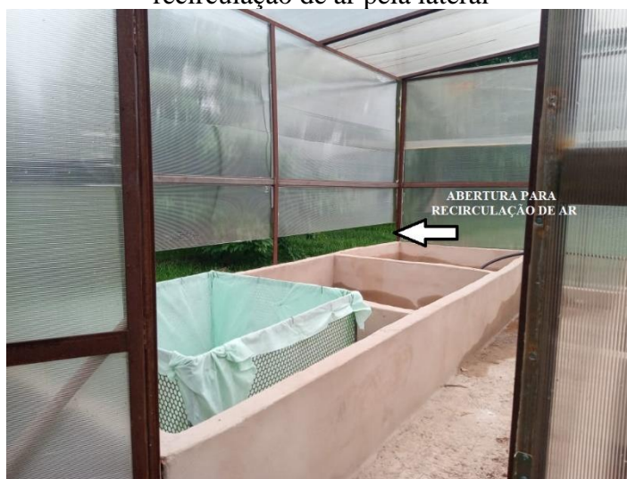
Figura 33. Representação interna lateral da estufa com indicação em destaque da abertura para recirculação de ar pela lateral
