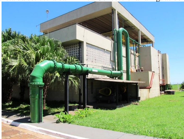
Figura 20. Vista da estrutura da ETA da Concessionária Águas de Mandaguahy
