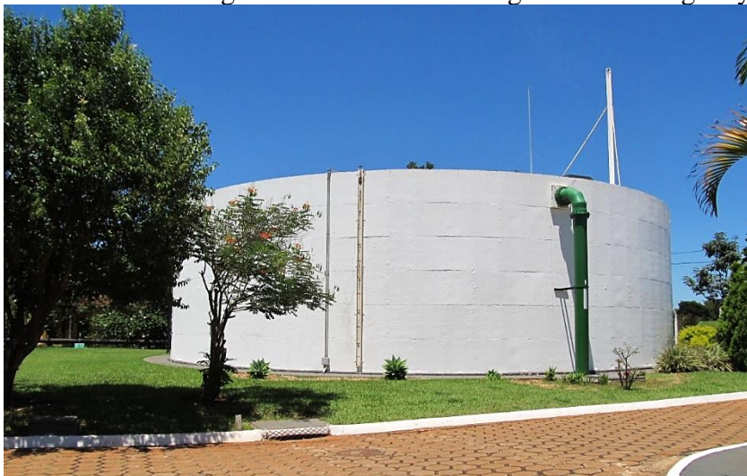
Figura 25. Reservatório com volume útil de 2.000 m 3 localizado nas dependências da estação de tratamento de água da Concessionária Águas de Mandaguahy
