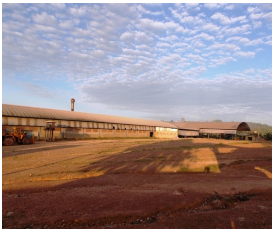
Figura 5 - Vista interna da Empresa Madeireira, localizada no município de Anapú-Pa
