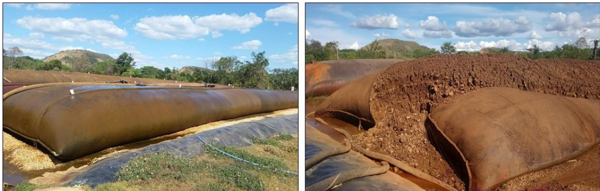
Figura 8: Imagem de um sistema de filtração em tubos geotêxteis (a esquerda, o sistema em operação; a direita, o geotêxtil em fim de operação com o resíduo já seco)
