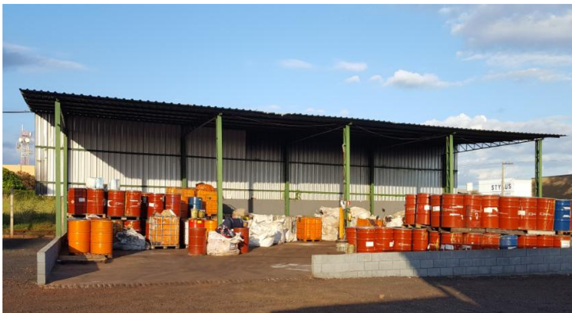
Figura 36: Local de triagem e armazenamento de resíduos
