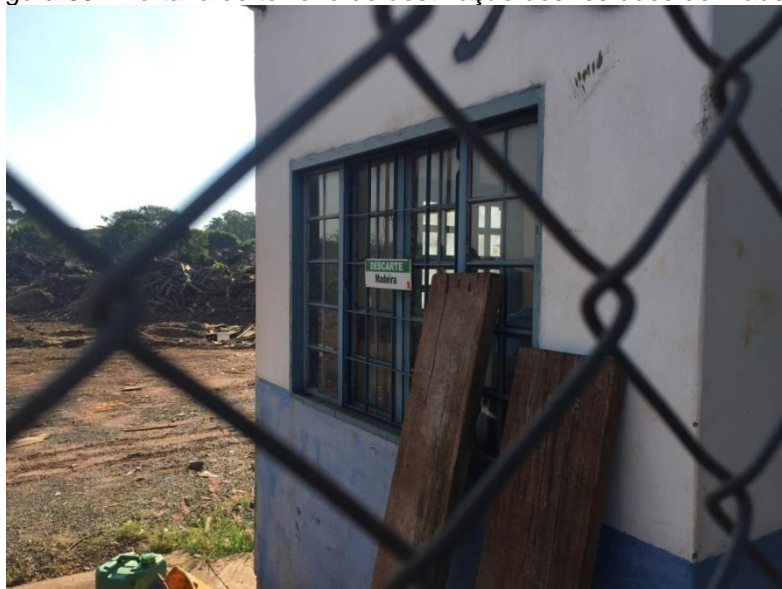
Figura 63 - Portaria do terreno de destinação dos resíduos de madeira
