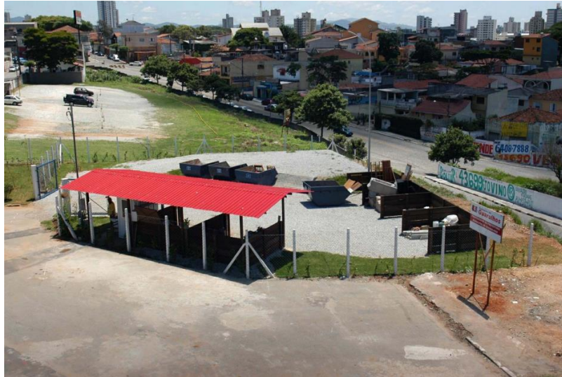
Figura 9 - PEV instalado em Guarulhos/SP.
