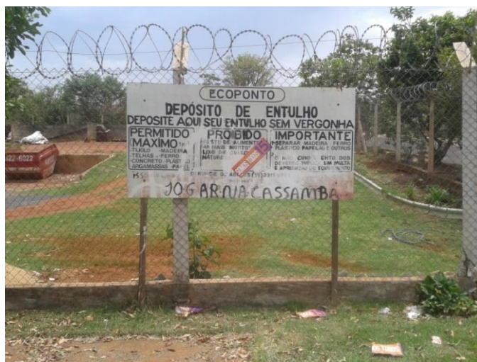
Figura 49 - Placa de identificação incorreta e danificada – Bairro: Morumbi – Uberaba/MG.
