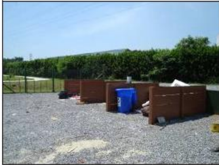
Figura 15 - Ecoponto com baias para armazenamento de resíduos leves – São José Dos Campos/SP.
