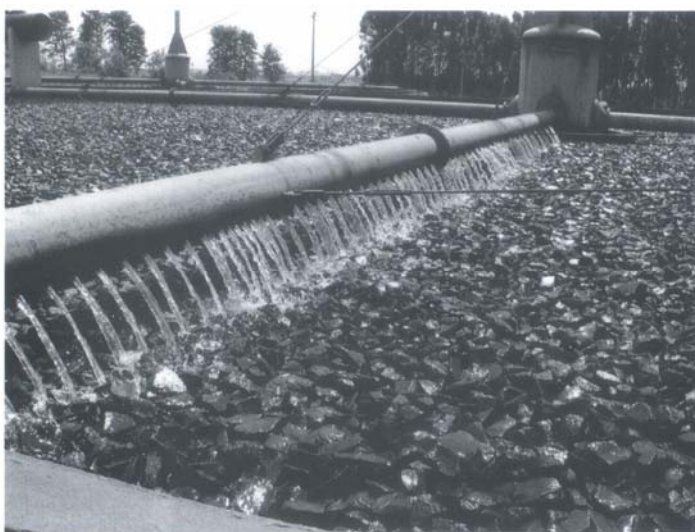
Figura 12 – Filtro biológico com leito de pedra (JORDÃO, 2005)
