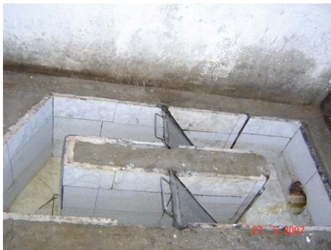
Figura 2 – Peneira para remoção de sólidos
