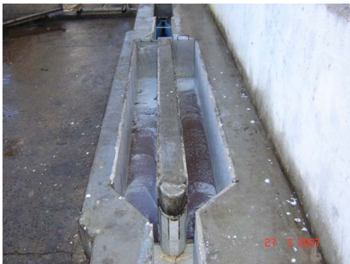
Figura 3 – Desarenador / Caixa de areia
