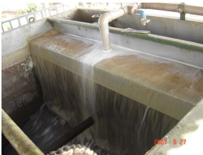
Figura 6 – Flotador de ar dissolvido em início de funcionamento
