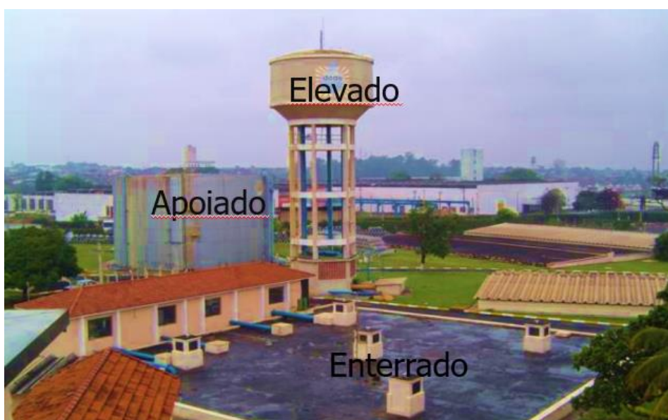
Figura 8: Reservatórios, elevado, apoiado e enterrado, estação de tratamento fonte - DAAE, Araraquara
