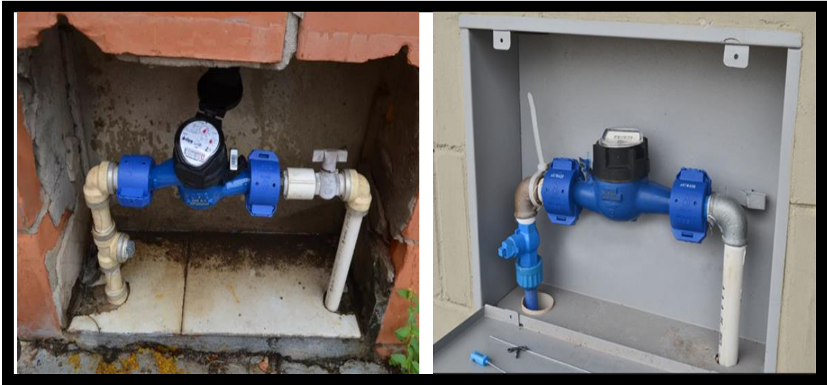
Figura 25: Imagem de ligação de água em cavalete residencial e em caixa padrão
