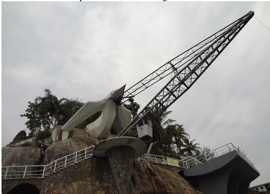
Figura 12 - Fênix, uma obra de concreto no formato de um gigantesco pássaro que dá apoio a um sistema de guindaste
