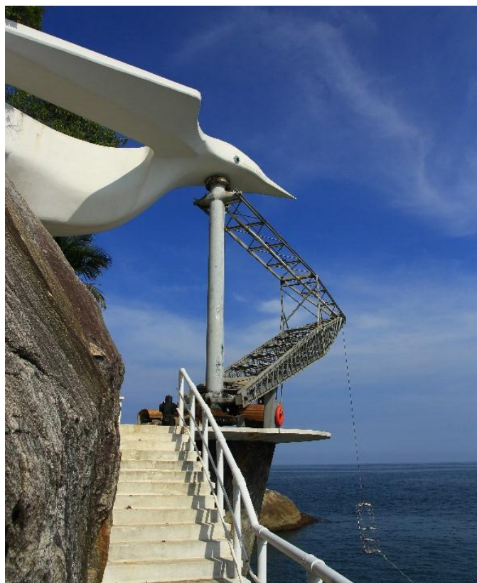
Figura 13 - Sistema de içamento para ingresso na Ilha dos Arvoredos
