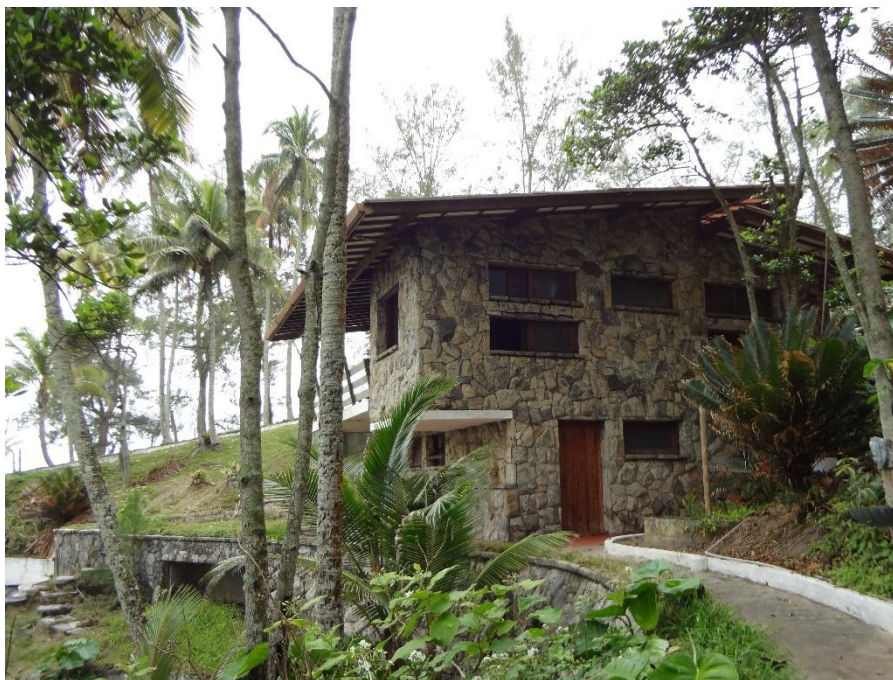
Figura 14- Residência construída na Ilha dos Arvoredos
