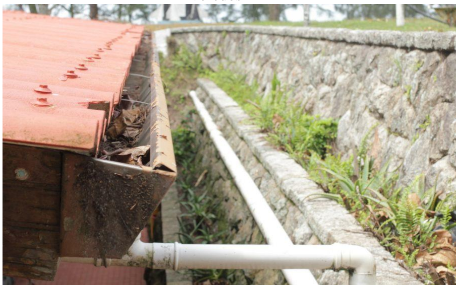
Figura 36 - Sistema de captação de água da chuva do telhado da residência da Ilha dos Arvoredos
