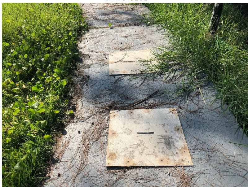
Figura 27 - Caixas de água potável captada pelo telhado da casa de pedras da Ilha dos Arvoredos
