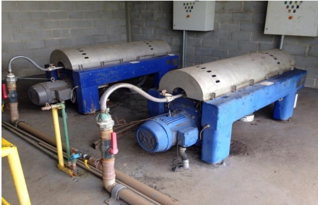
Figura 13. Centrifugas usadas na desidratação do lodo obtido do tratamento da ETE Salto do Guimarães.
