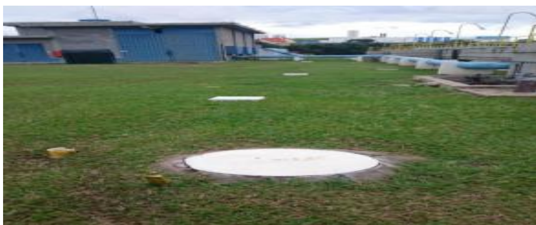
Figura 25. Nova infra - estrutura para passagem dos novos cabos do sistema de automação da ETE Salto do Guimarães.
