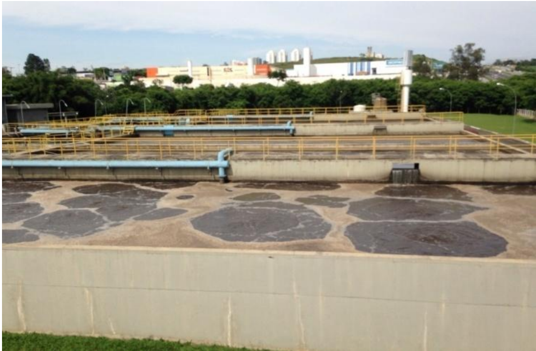
Figura 11. Vista superior dos Reatores de lodos ativados por batelada sequencial alternada da ETE Salto do Guimarães.
