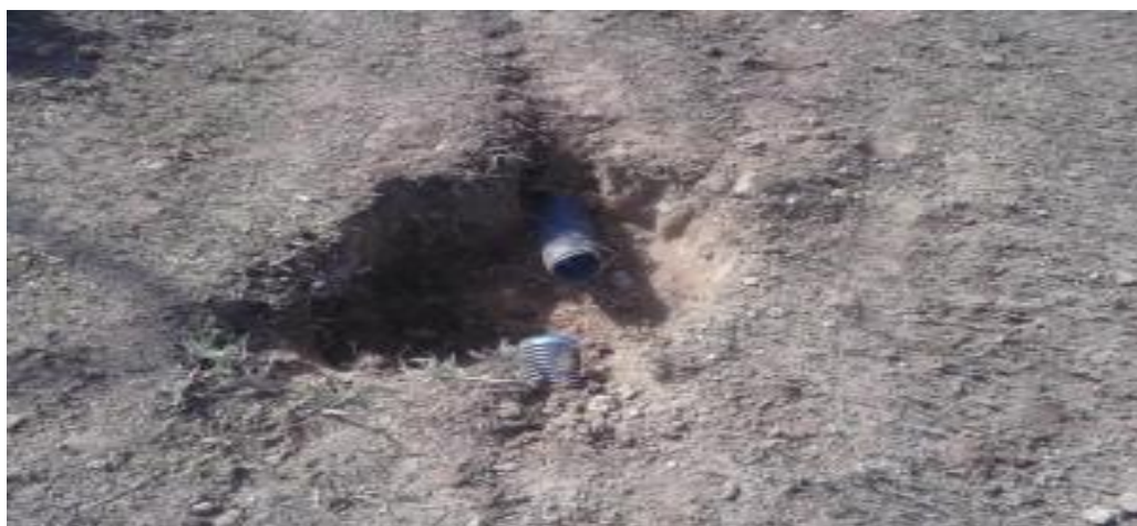
Figura 24. Implantação de nova infra - estrutura do sistema de automação da ETE Salto do Guimarães.
