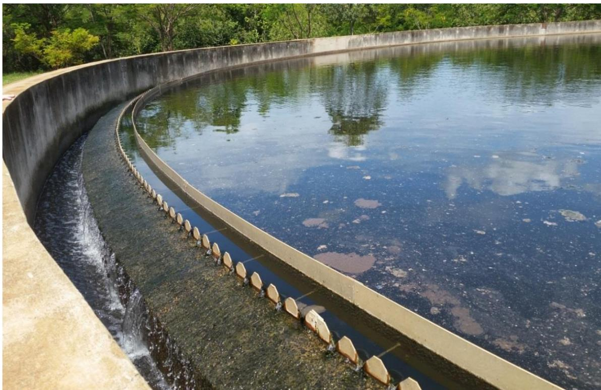
Figura 5 Efluente do sedimentador da ETE Caiçara de Ribeirão Preto.
