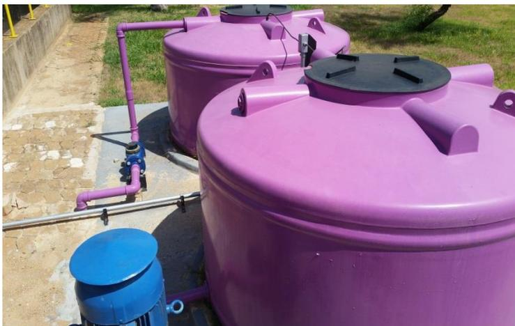
Figura 14 Reservatório de água de Reúso após adição de cloro da ETE Caiçara.
