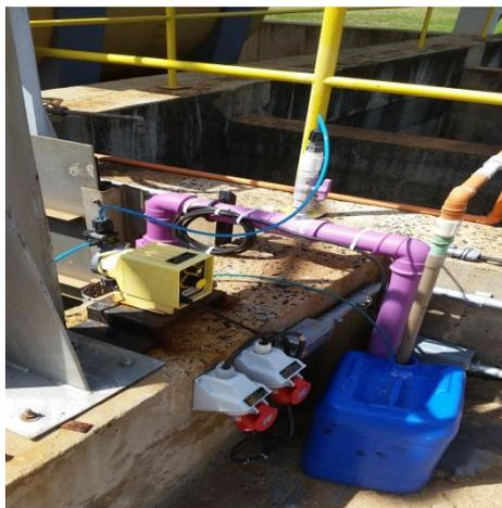
Figura 13 Ponto de aplicação de cloro no efluente da ETE Caiçara.
