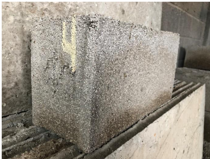
Figura 94. Bloco de concreto da Amostra 04
