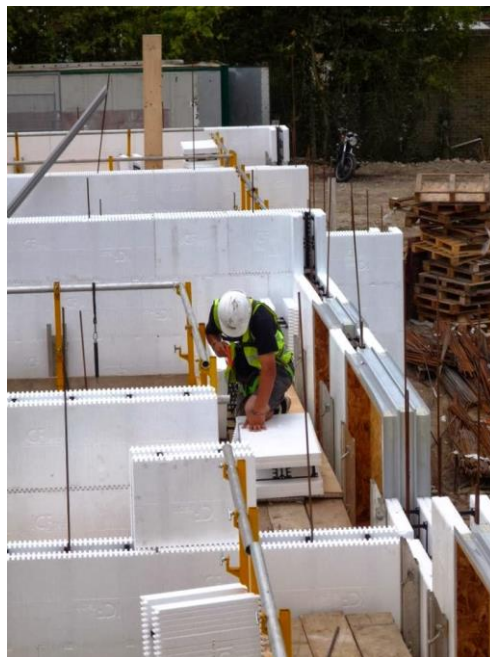
Figura 39. Detalhe do recorte de blocos vazados de EPS
