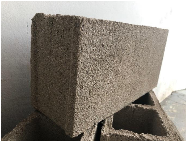
Figura 95. Bloco de concreto da Amostra 05
