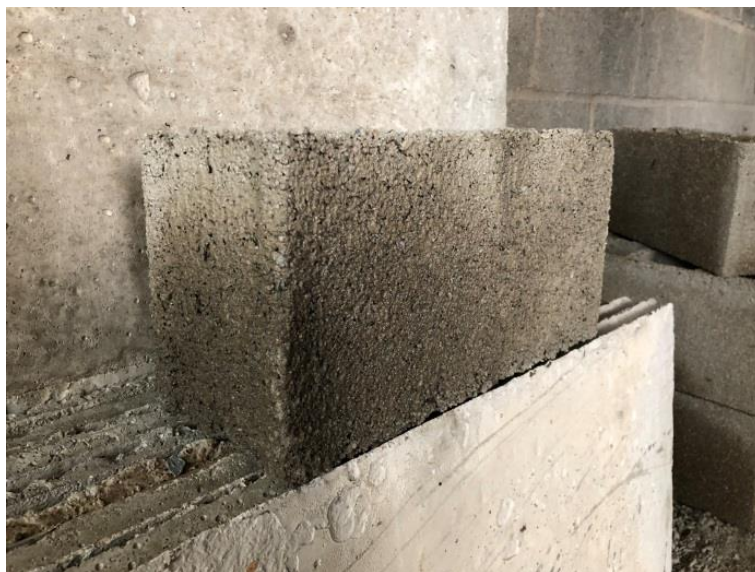
Figura 89. Bloco de concreto convencional com areia e brita
