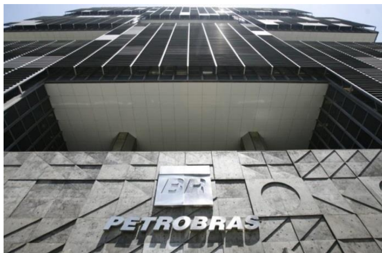
Figura 19. Fachada do edifício da Petrobrás no Rio de Janeiro/RJ - Detalhes recortados no concreto
