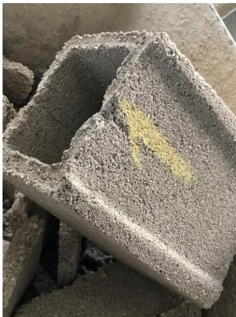
Figura 123. Bloco de concreto com redução de 10% do agregado (areia) após o teste de resistência
