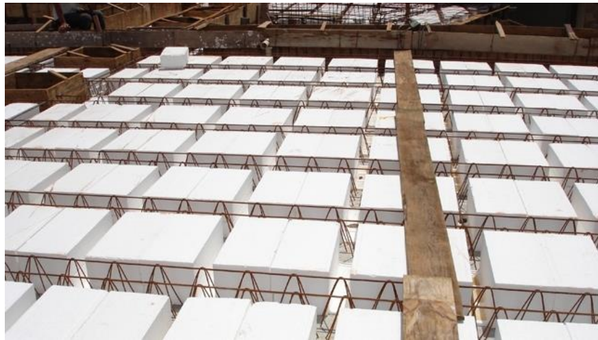
Figura 22. Laje nervurada bidirecional com EPS
