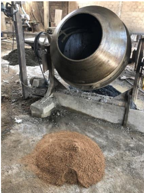
Figura 59. Areia separada para o desenvolvimento das Amostras dos blocos de concreto
