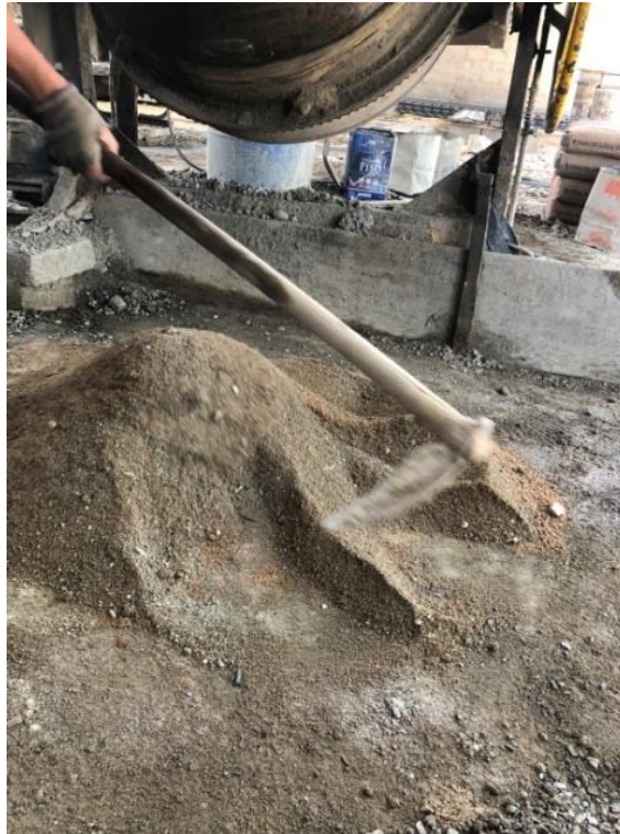
Figura 60. Cimento sendo misturado com a areia para o desenvolvimento das Amostras dos blocos de concreto
