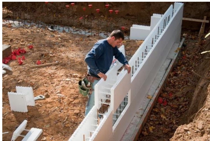
Figura 38. Detalhe do encaixe de blocos vazados de EPS
