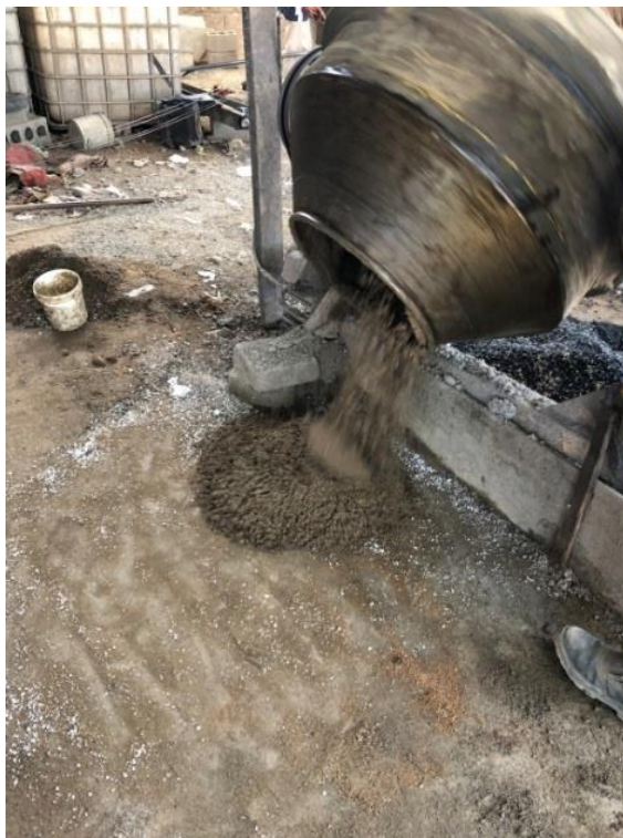
Figura 63. Material pronto sendo retirado da betoneira para as Amostras dos blocos de concreto
