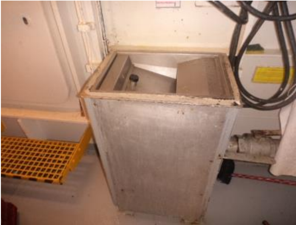
Figura 28: Triturador Alimentar no setor de convés em uma unidade SESV
