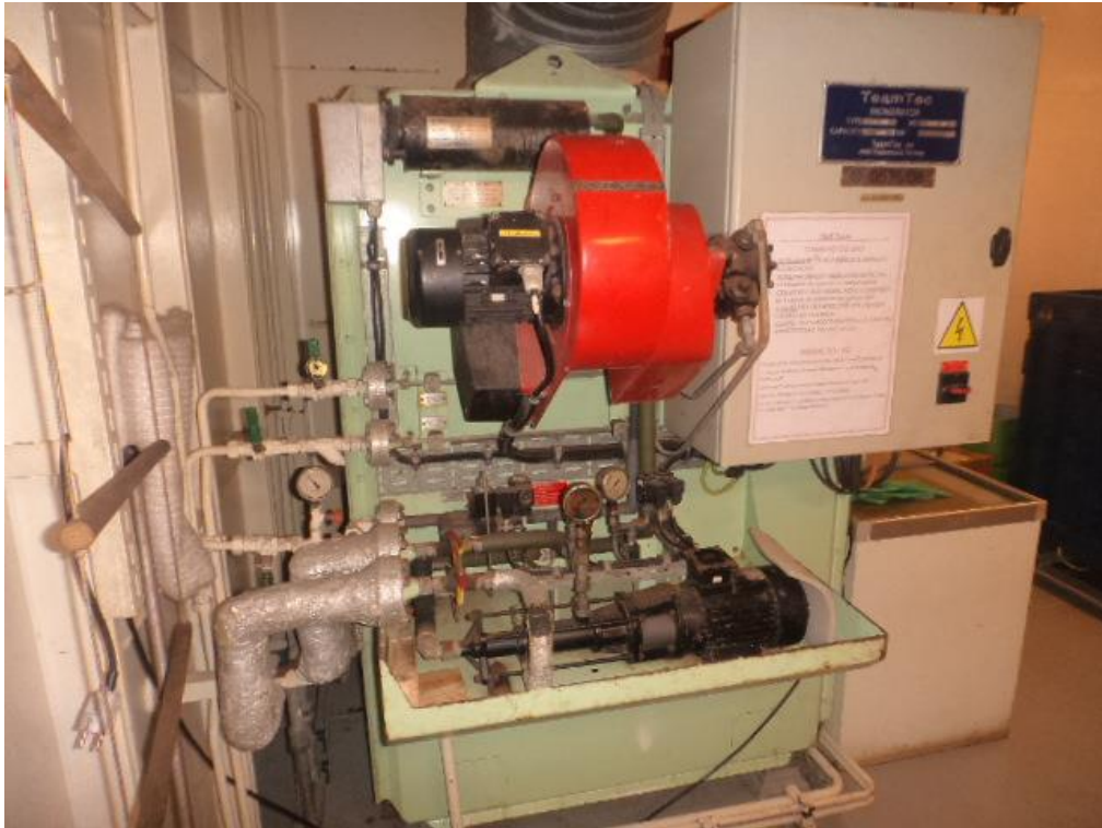
Figura 32: Conjunto para incineração no setor de convés em uma unidade SESV
