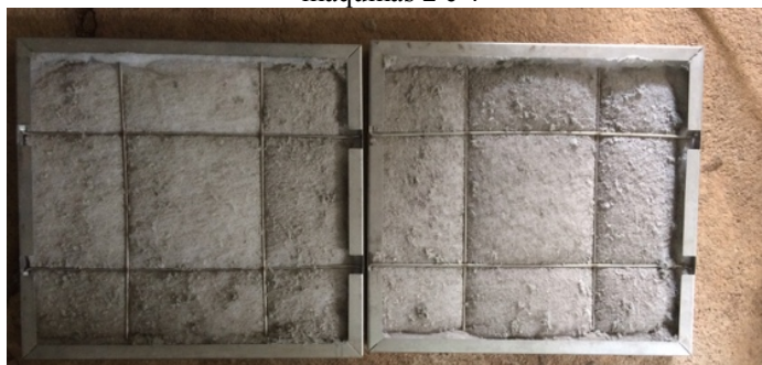
Figura 49: Filtros G4 na grelha 500 mm x 500 mm, usado nas máquinas 2 e 4
