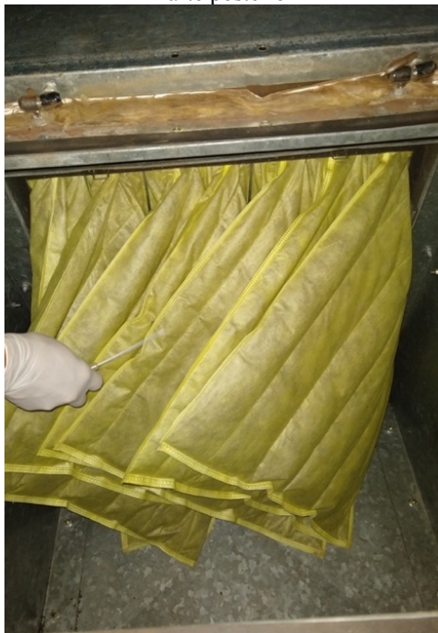
Figura 57: Coleta de amostra no filtro F8 - Parte posterior
