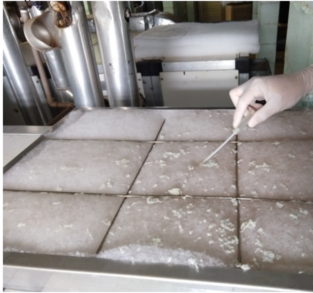
Figura 58: Coleta de amostra no filtro G4 – Parte frontal
