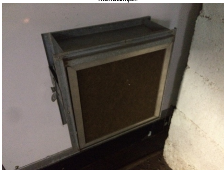
Figura 41: Filtro G1 de uma das máquinas do EAS 3 antes da manutenção
