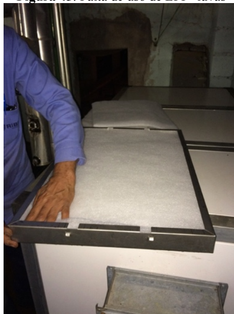
Figura 45: Falta de uso de EPI - luvas
