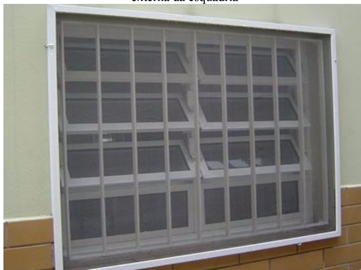
Figura 86: Exemplo de uso de tela de proteção instalada na parte externa da esquadria
