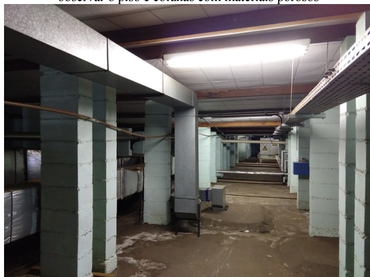
Figura 33: Corredor principal do pavimento técnico onde pode-se observar o piso e colunas com materiais porosos
