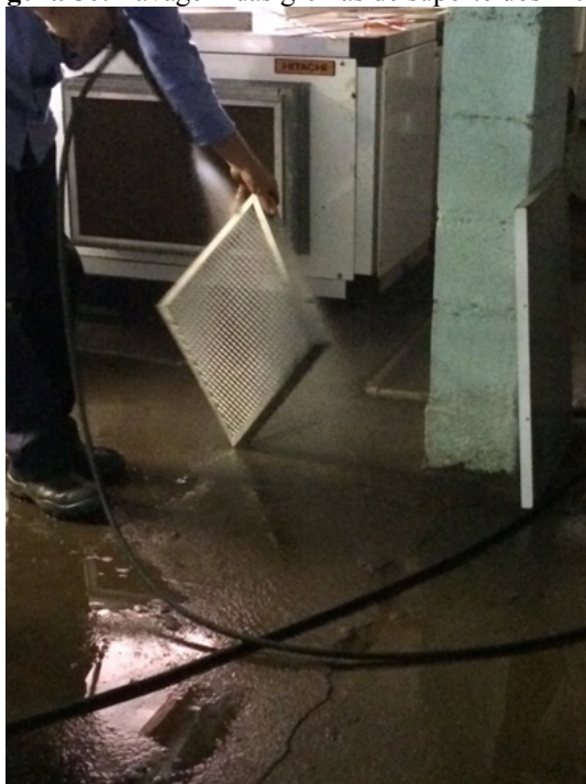
Figura 50: Lavagem das grelhas de suporte dos filtros
