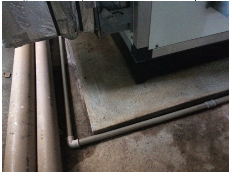
Figura 32: Piso do pavimento técnico em cimentado poroso
