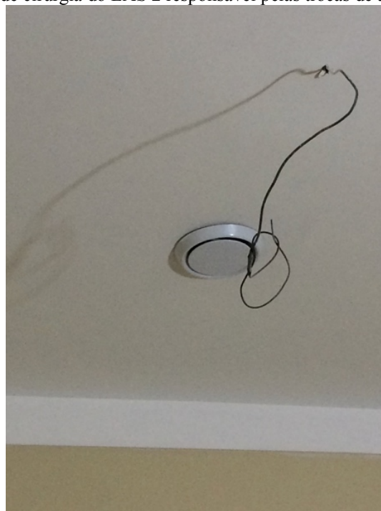
Figura 25: Exaustor de modelo residencial na sala de cirurgia do EAS 2 responsável pelas trocas de ar
