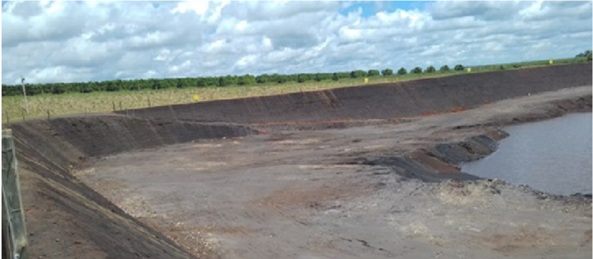
Figura 8 - Aterro próprio da empresa A
