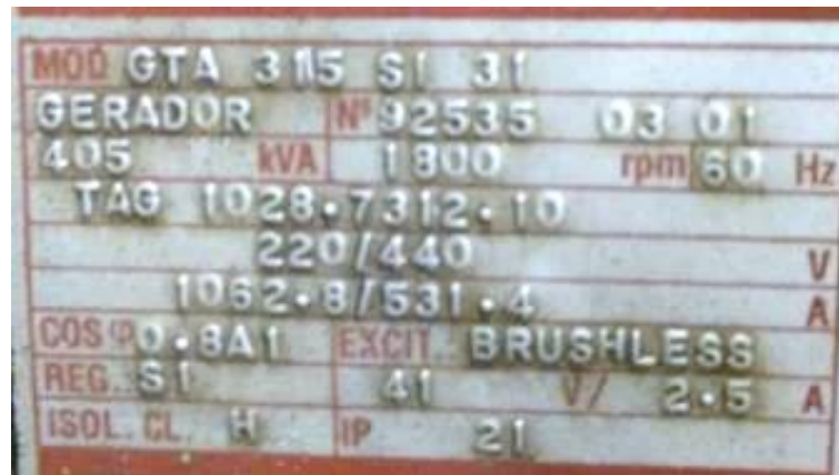
Figura 21 – Foto de uma placa de identificação de GGED encontrado durante o levantamento dos GGED existentes na região central de Ribeirão Preto.
