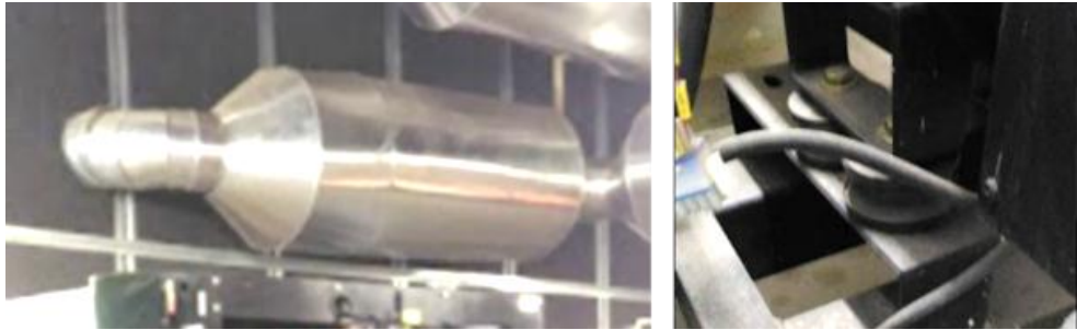
Figura 35 – Fotos de um silenciador (à esquerda) e um isolador de vibração (à direita) identificados durante as visitas aos GGED.
