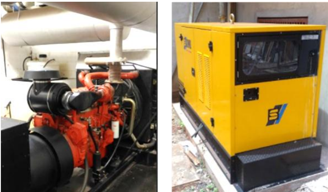
Figura 36 – Fotos de GGED em sala de alvenaria (à esquerda) e com carenagem (à direita), respectivamente, identificados neste estudo.
