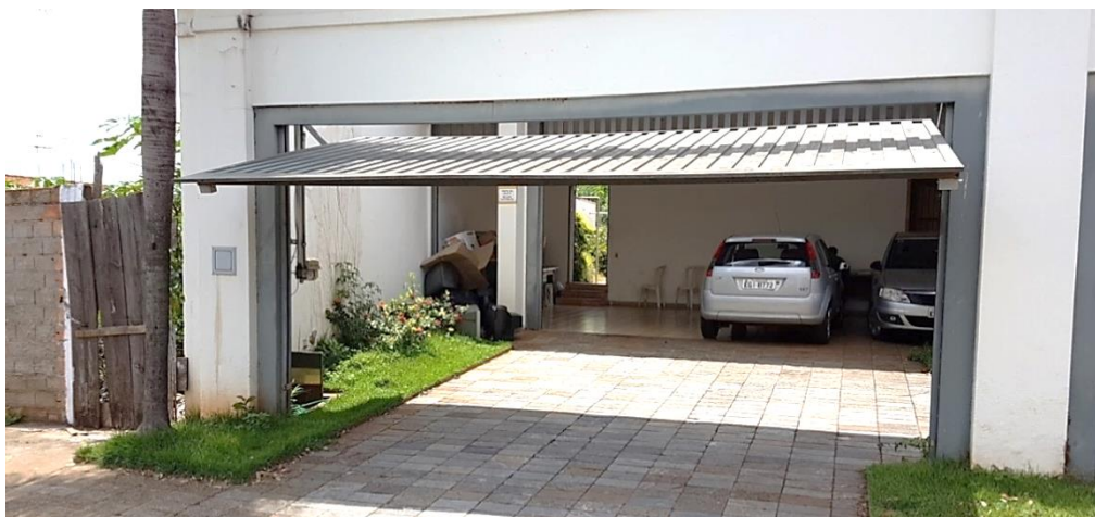
Figura 14 - Local do PEV junto à lateral esquerda da garagem
