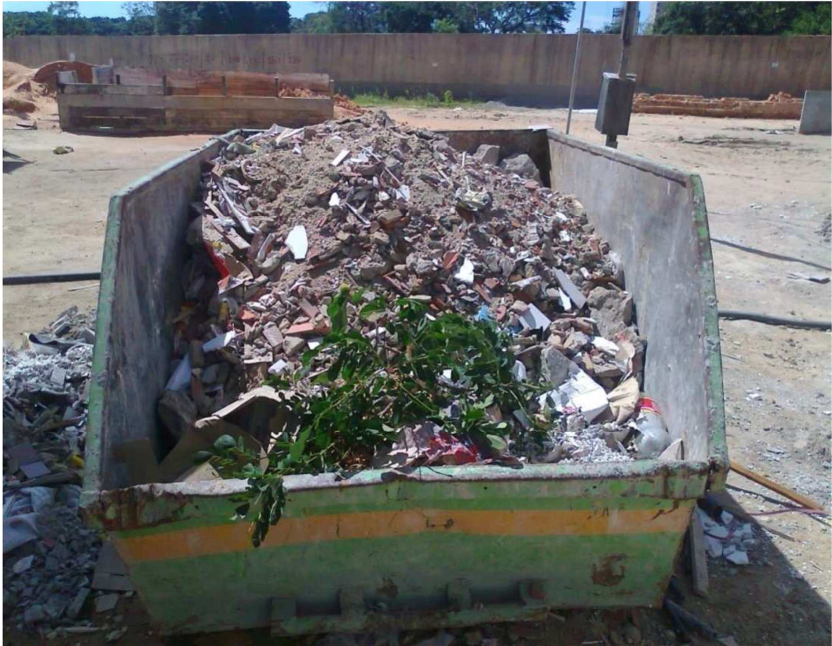
Figura 5 – Caçamba estacionária para coleta de RCC – mistura de materiais
