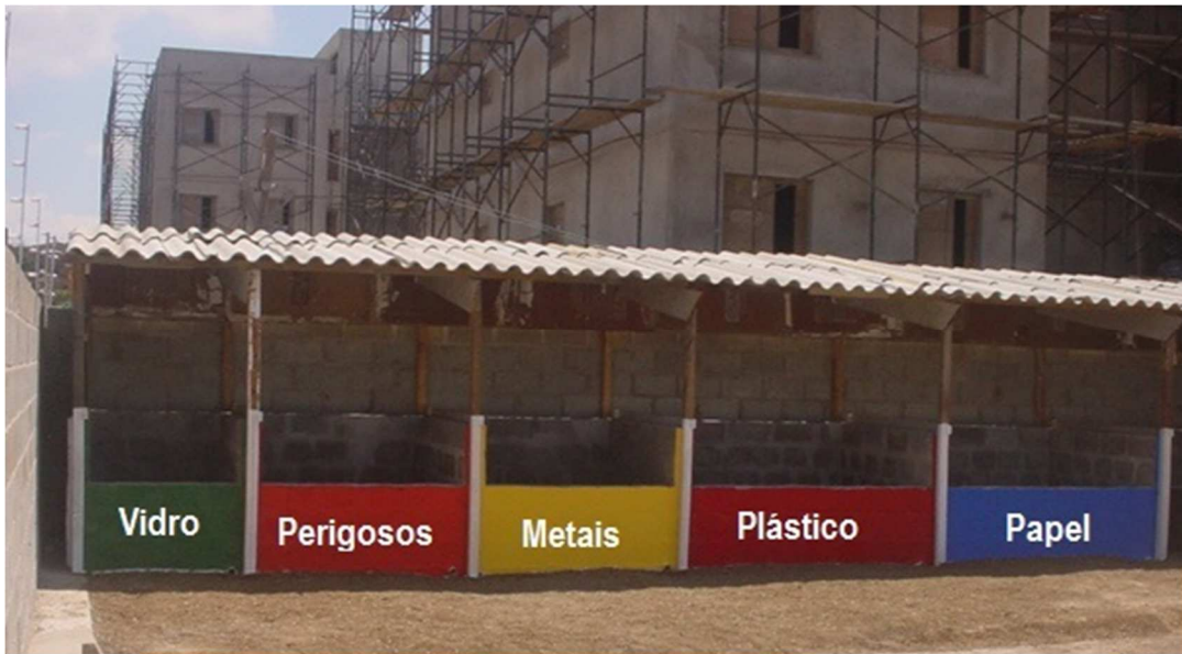
Figura 3 – Baias para separação e acondicionamento de RCC no canteiro
