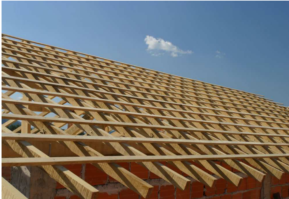
Figura 13 – Execução de estrutura de madeira para cobertura com telha cerâmica
