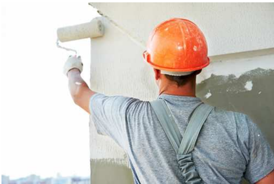
Figura 28 – Pintura de parede com tinta látex
