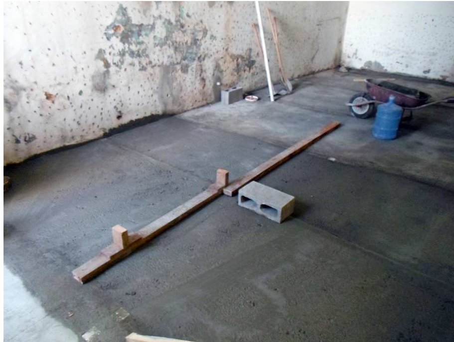
Figura 15 – Regularização para assentamento de piso cerâmico
