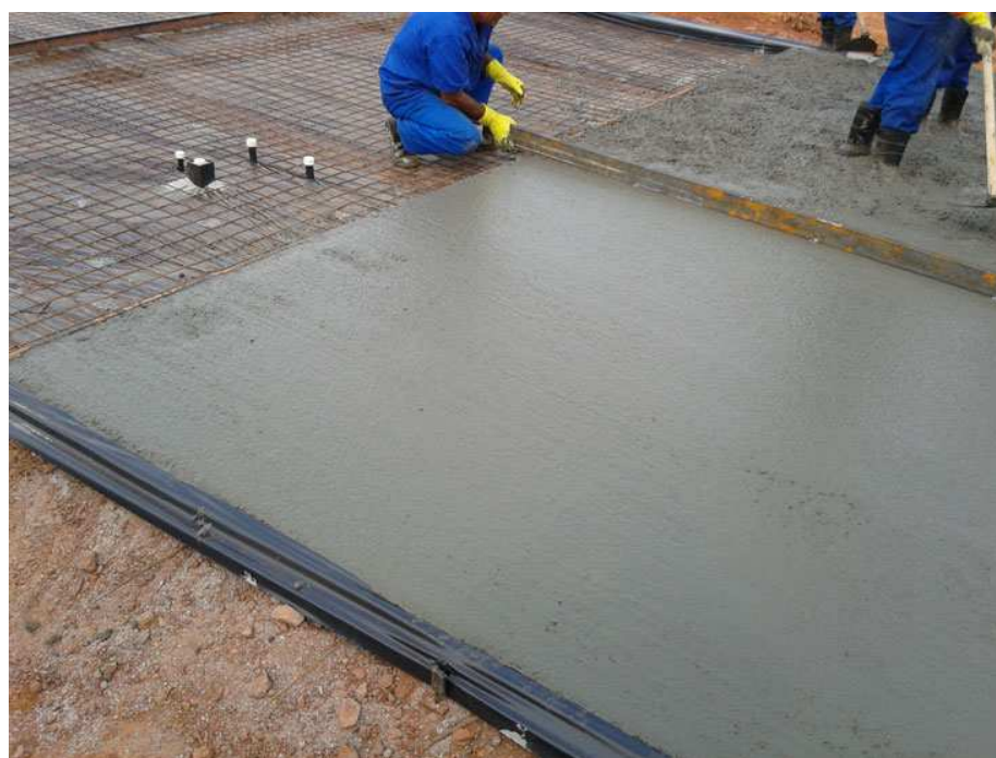
Figura 10 – Concretagem de radier
