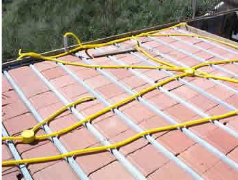
Figura 23 – Instalação de eletrodutos antes da concretagem da laje
