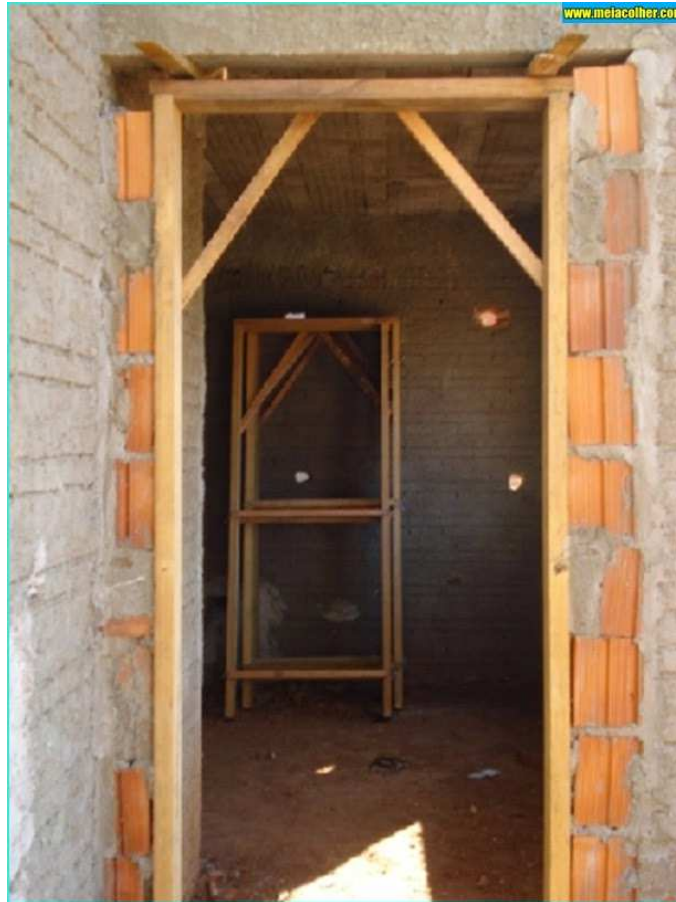
Figura 17 – Fixação de batente de madeira
