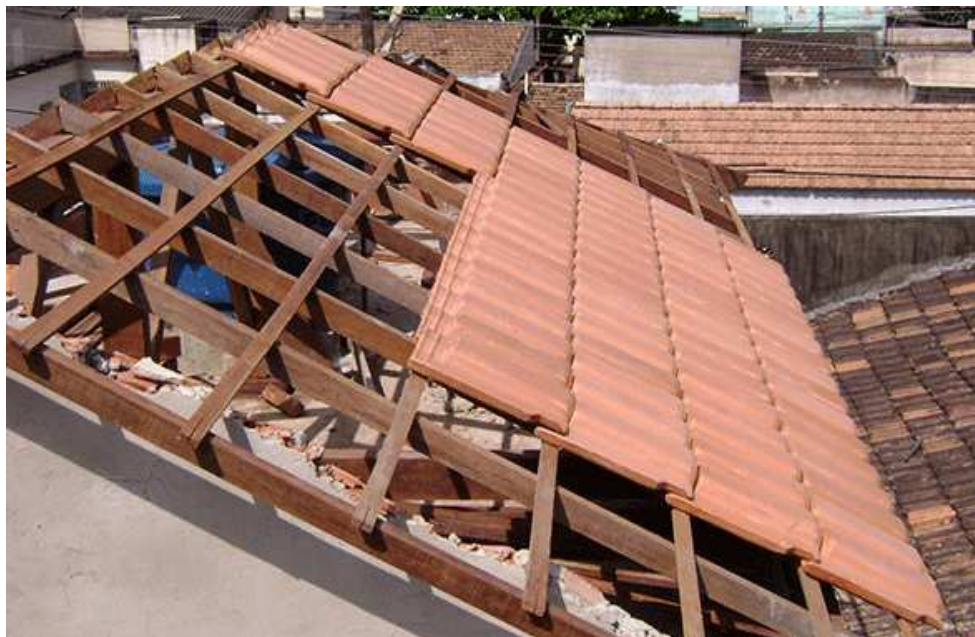
Figura 14 – Cobertura com telha cerâmica
