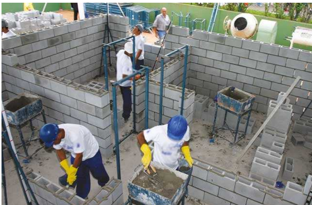
Figura 11 – Execução de alvenaria em bloco de concreto estrutural
