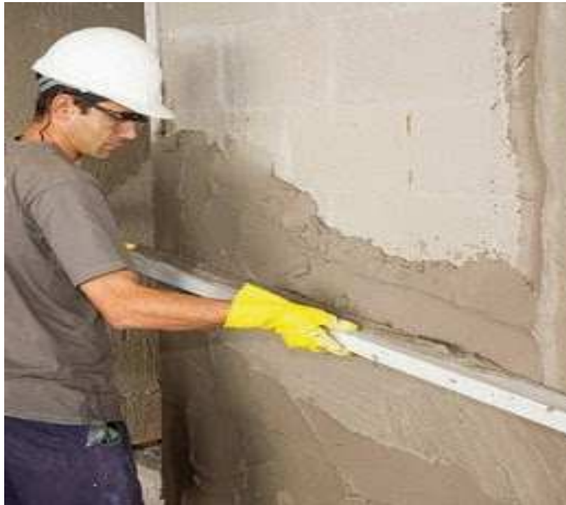
Figura 19 – Execução de revestimento com argamassa
