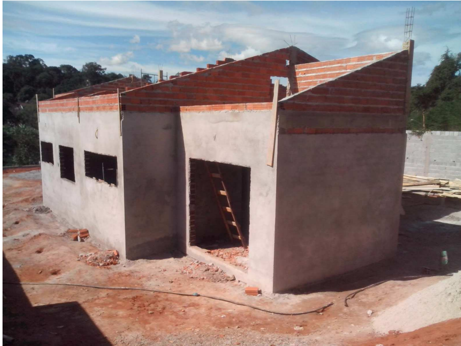
Figura 20 – Revestimento externo
