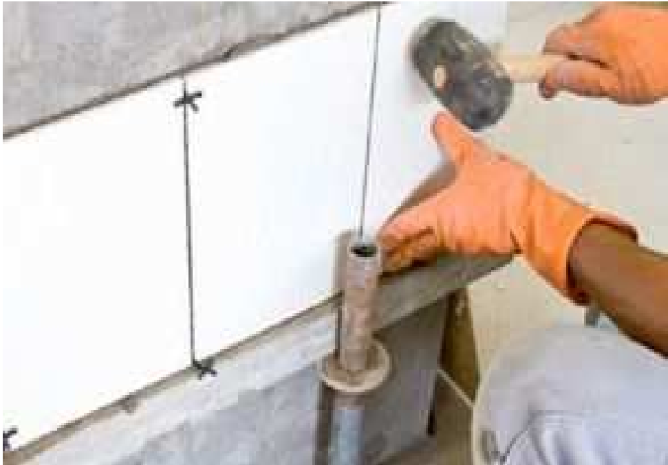
Figura 21 – Revestimento cerâmico de paredes
