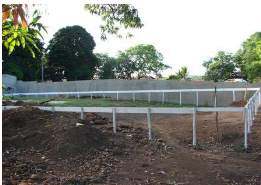
Figura 9 – Gabarito de madeira para locação de obra
