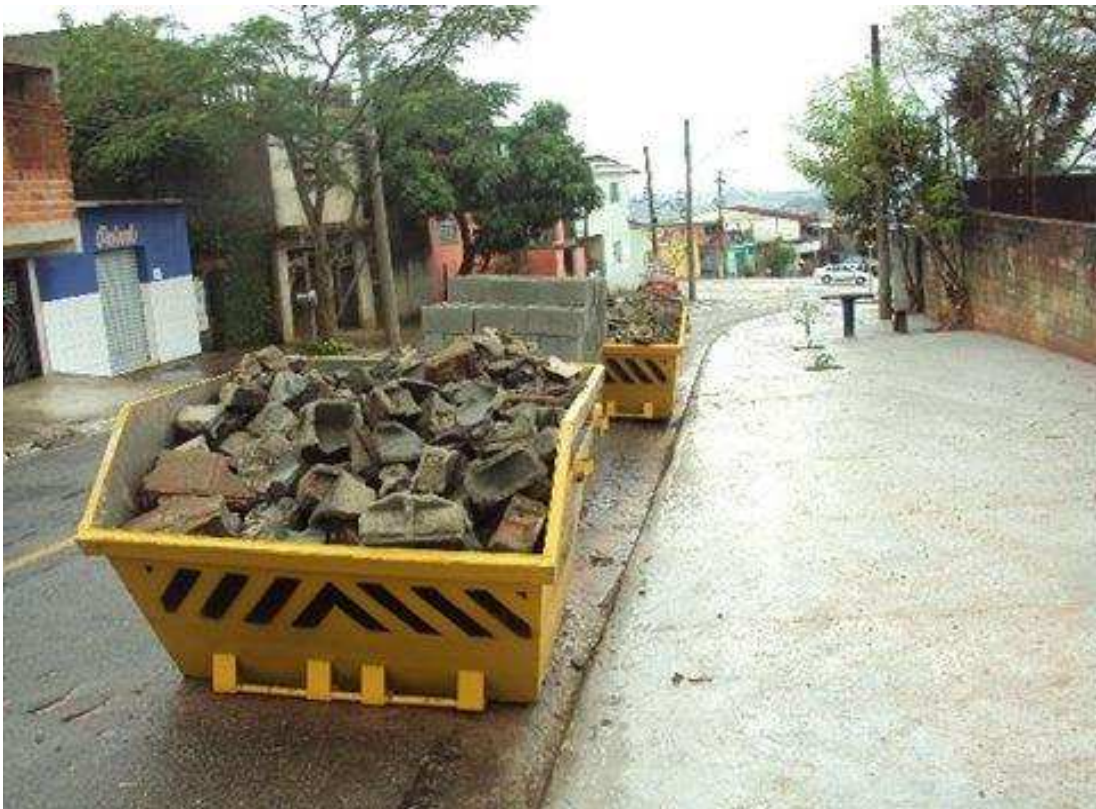
Figura 4 – Caçamba estacionária para acondicionamento e remoção de RCC
