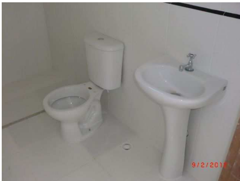
Figura 27 – Instalação de louças e metais sanitários
