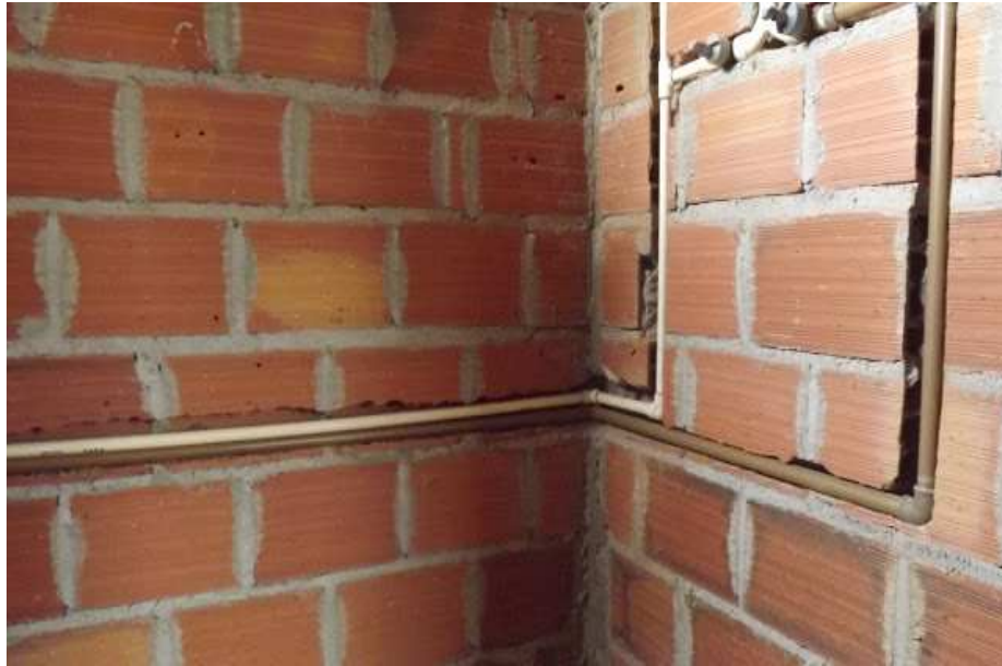
Figura 26 – Instalação de tubulação de água em paredes
