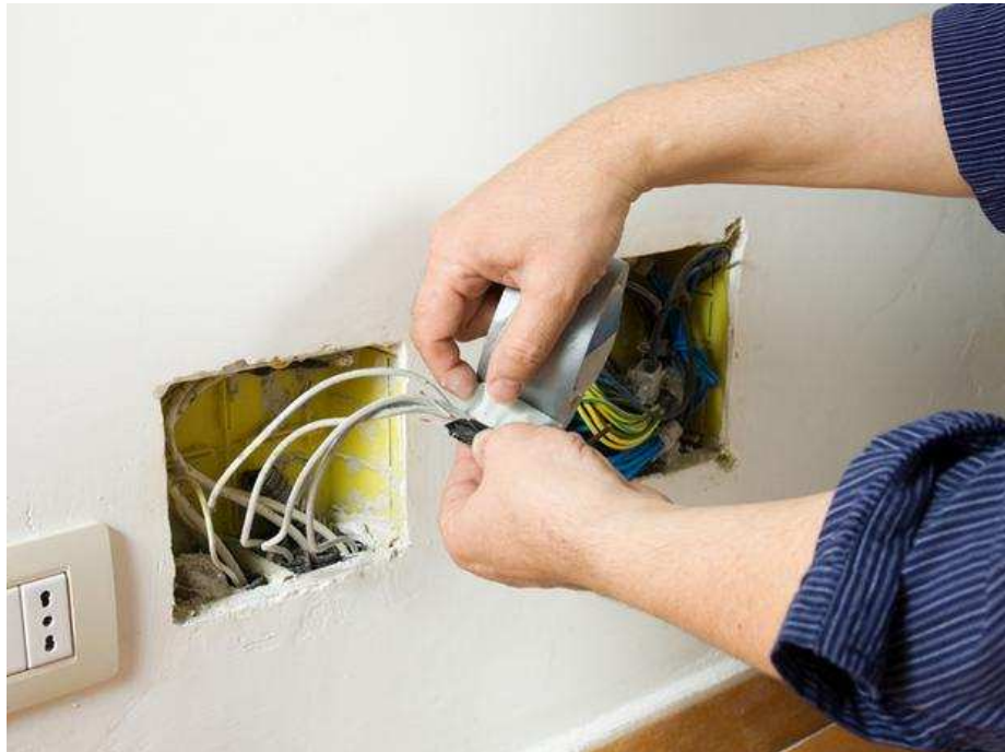
Figura 24 – Instalação de interruptores e tomadas
