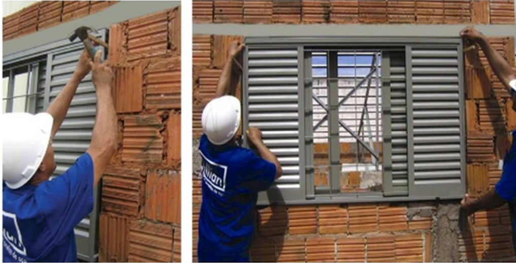
Figura 16 – Assentamento de esquadrias metálicas
