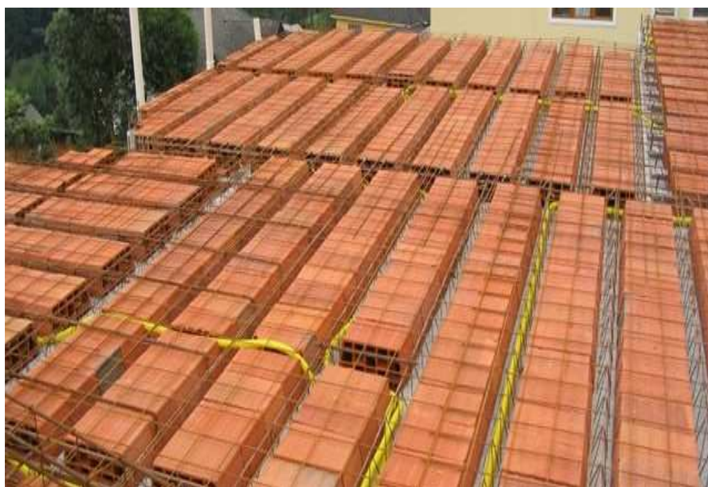
Figura 12 – Preparação e montagem de laje
