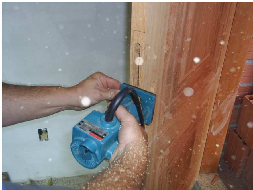
Figura 18 – Instalação de porta de madeira
