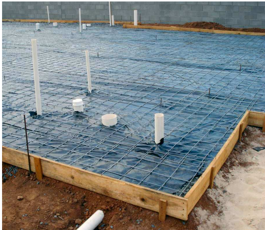
Figura 25 – Tubulações instaladas na preparação do radier
