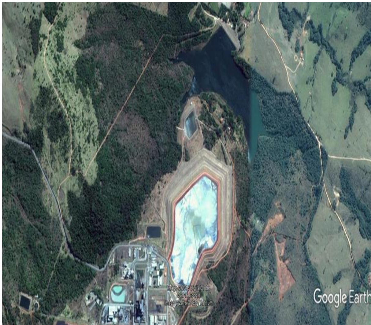
Figura 14 - Visão da barragem de rejeito da mineradora no município de Fortaleza de Minas-MG
