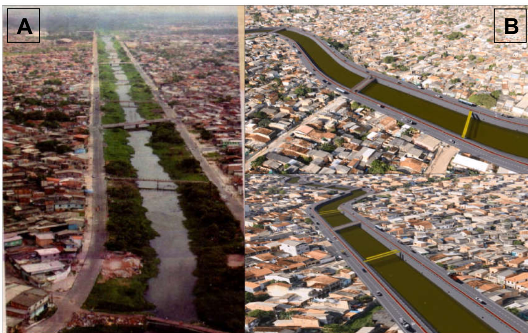
Figura 14: A) Canal após obras do projeto de macrodrenagem, com asfalto nas marginais. Nas marginais, gramíneas e mato. B) Projeto idealizado.
