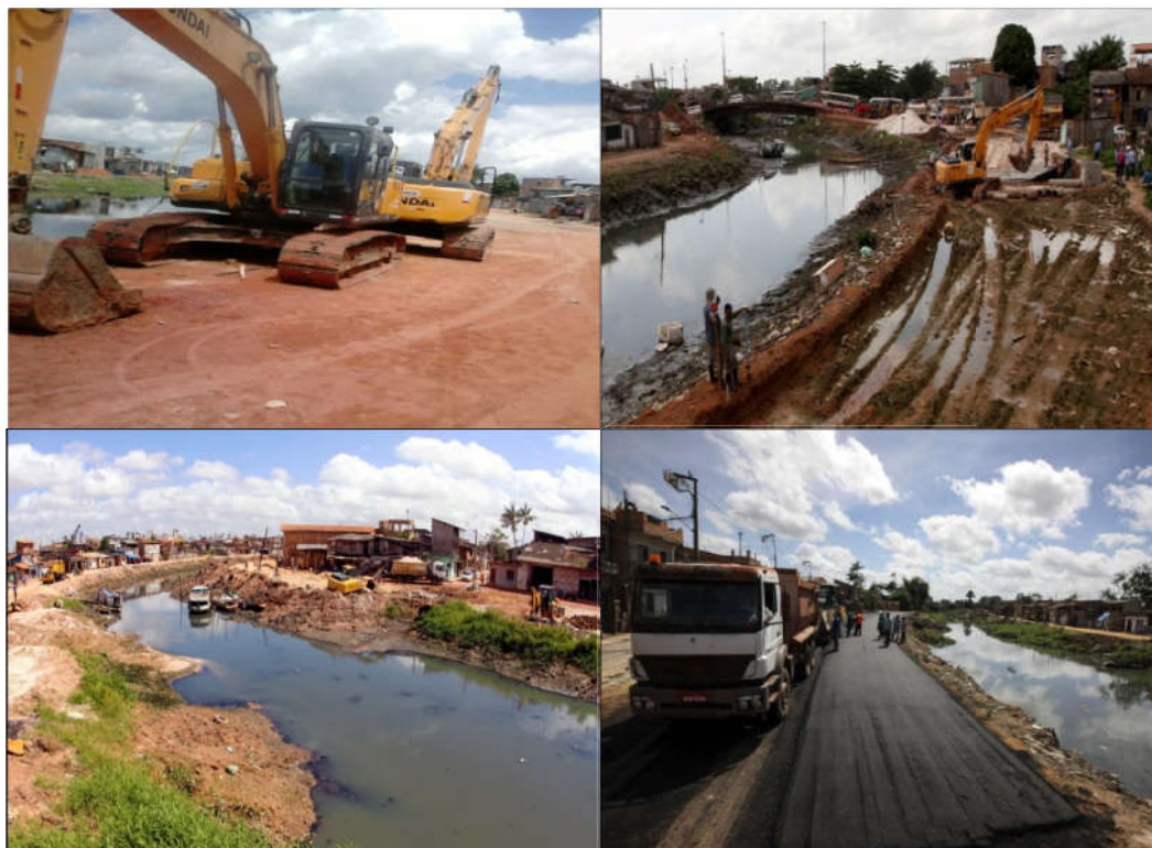
Figura 12: Máquinas trabalhando nas obras do Projeto “Saneamento Integrado na bacia do Tucunduba”
