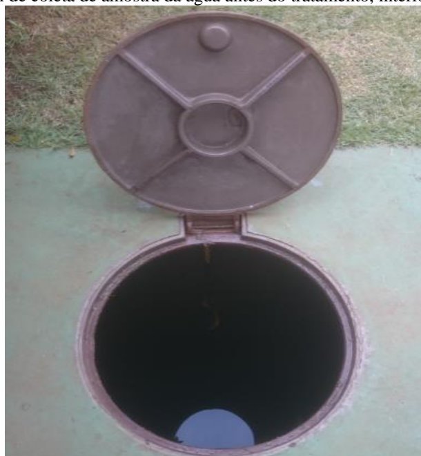
Figura 7: Local de coleta de amostra da água antes do tratamento, interior do reservatório
