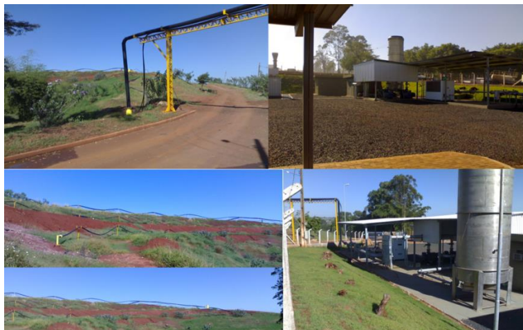
Figura 1.10 - Vista das instalações da Energás no Aterro Sanitário antigo
