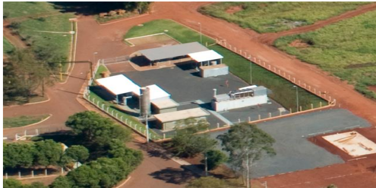
Figura 1.9 – Vista da planta da Energás no Aterro Sanitário antigo
