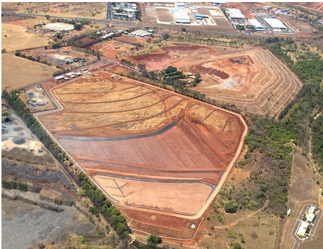
Figura 2.15 Vista aérea dos Aterros Sanitários de Uberlândia.
