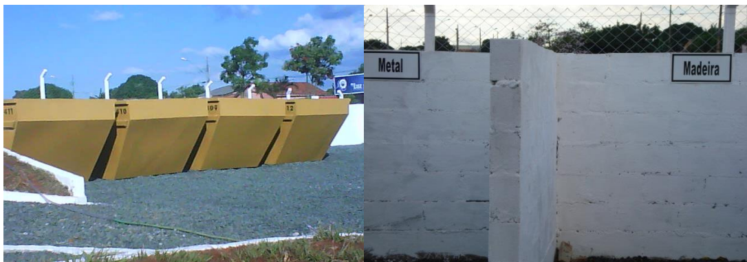
Figura 2.14 - Caçambas para descarte de Entulho / Baias.
